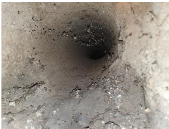
Schoorsteen woning geïnspecteerd.
