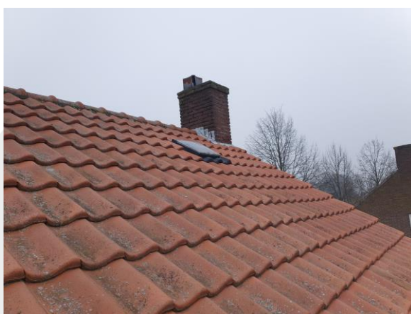
Strak dak. Nokvorsten aangesmeerd.
