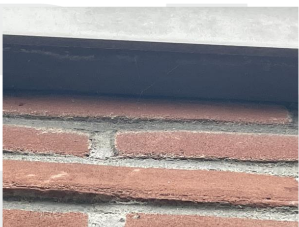
Strakke boeiboorden aanbouw.
