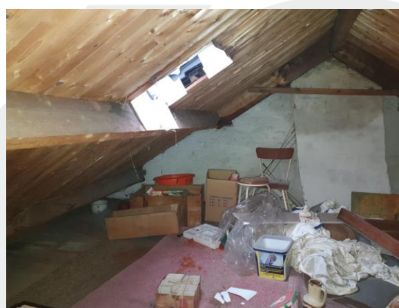
Zolder van de woning geïnspecteerd.
