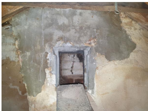
Schoorsteen woning geïnspecteerd.
