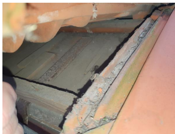
Ruimtes onder de pannen geïnspecteerd. Geen nestmateriaal aangetroffen.
