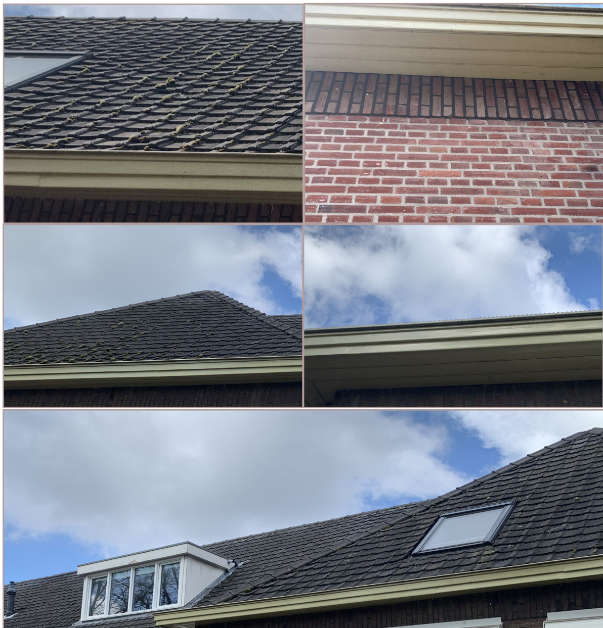
Figuur 2 Detailfoto's van het pannendak en betimmeringen.
