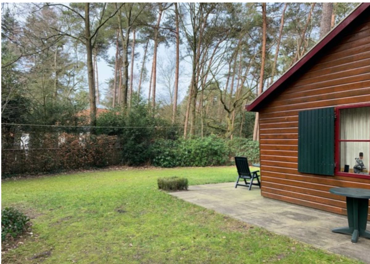
De achterzijde van één van de bestaande gebouwtjes
