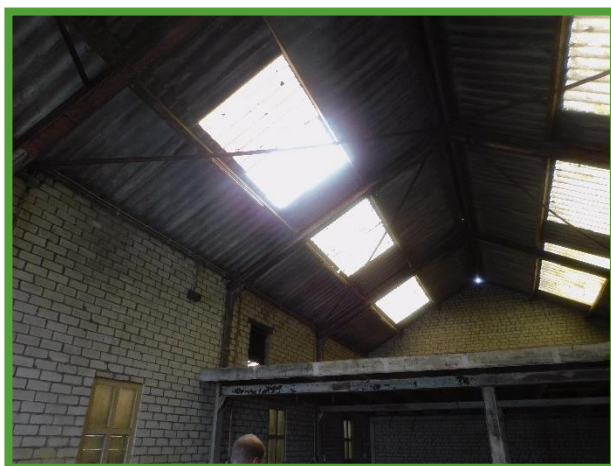
niet geïsoleerd dak van loods en stal
