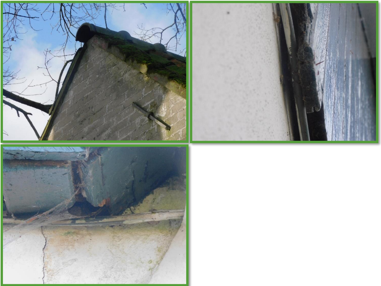
overzicht van structuren waar mogelijk vleermuizen kunnen verblijven
