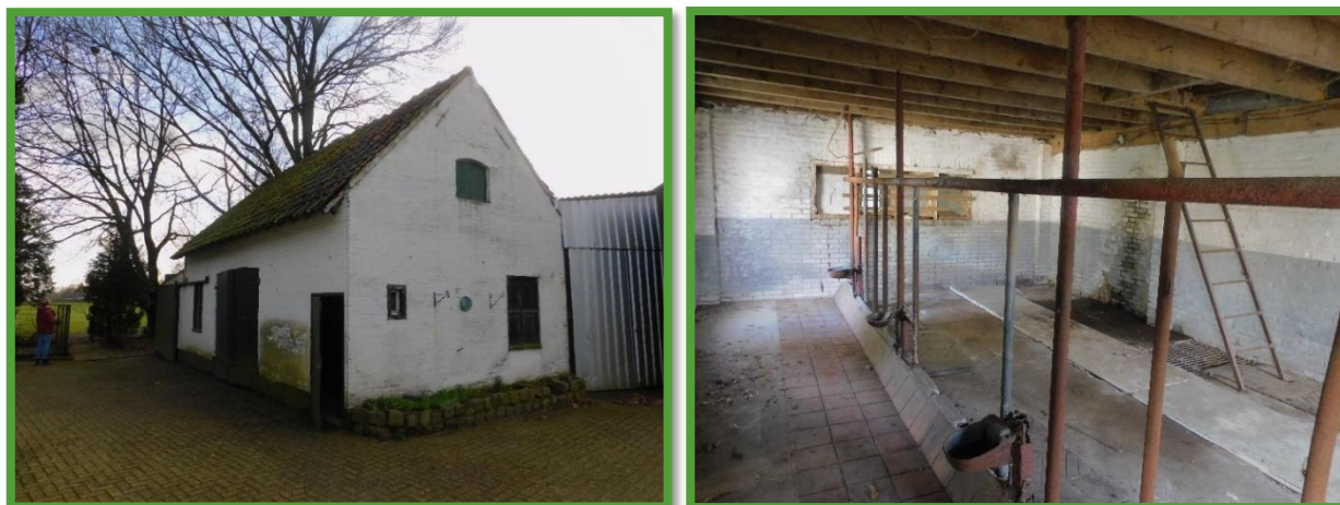
stal met overzicht binnenkant
