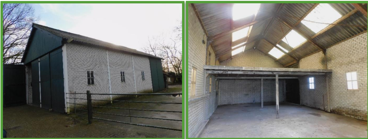
overzicht loods en binnenzijde
