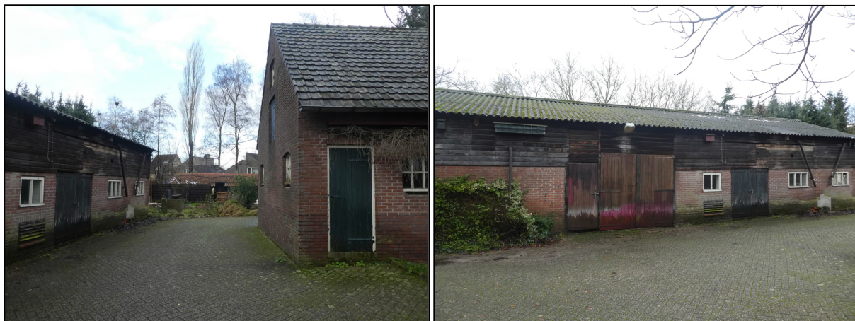
Figuur 7: Foto's plangebied in huidige situatie (2)
