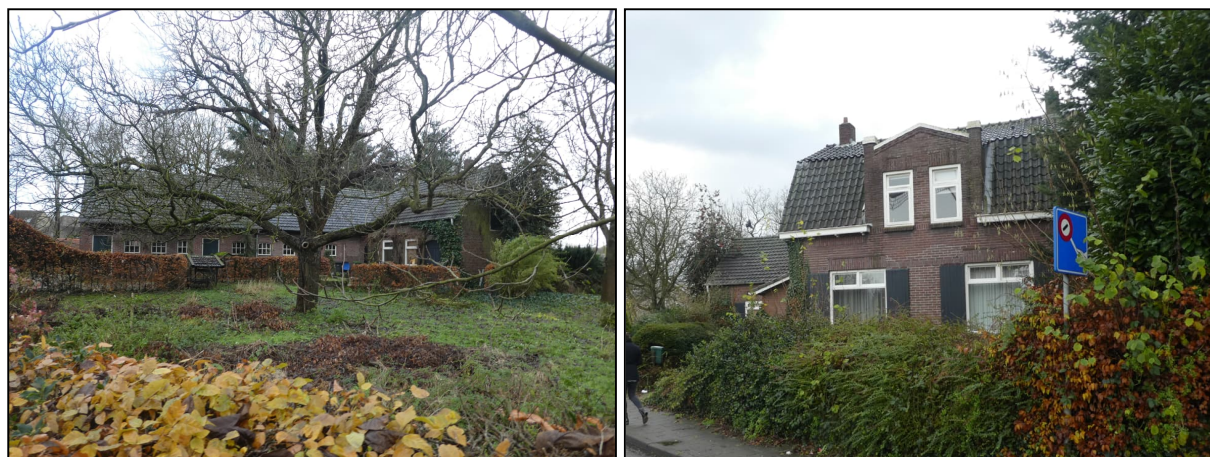
Figuur 6: Foto's plangebied in huidige situatie (1)
