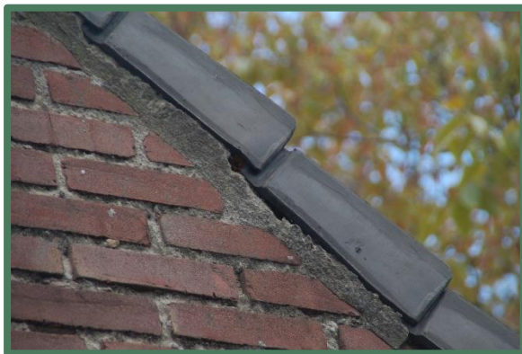
Mogelijke openingen voor verblijfplaatsen van vleermuizen
