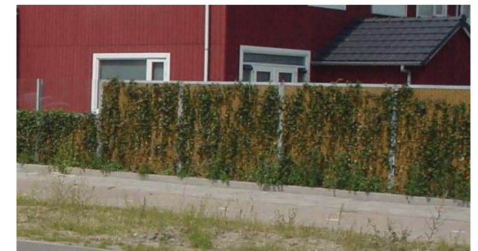
Referentiebeelden van geluidsschermb (kokowall) met begroeiing. Bovenste afbeelding bij aanplant, onderste na verloop van tijd.
