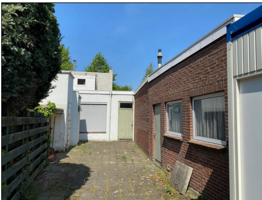
Afbeelding 4: Fotoweergave huidige situatie achterzijde projectlocatie. (Bron: Elzen Winkelman Makelaars)
