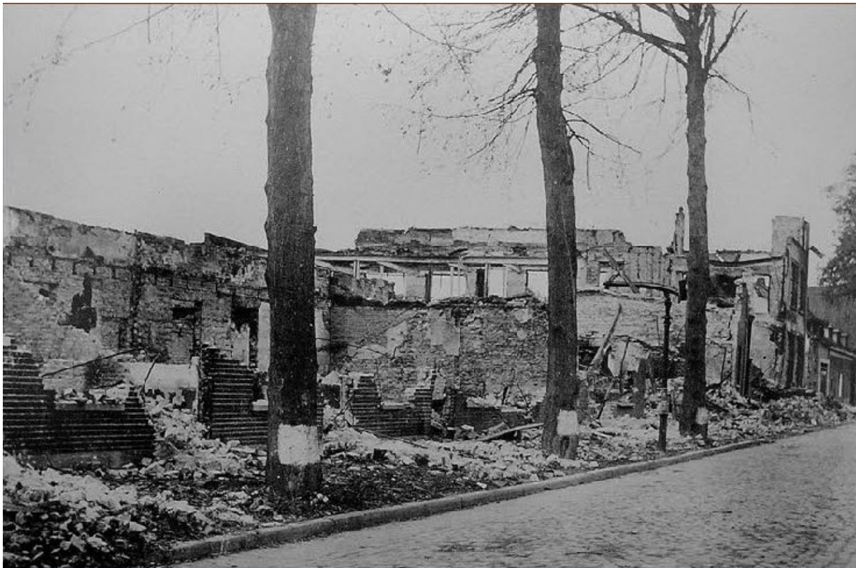
Figuur 14: De schade aan de bebouwing langs de Spoorlaan na de explosie van de munitietrein op 16 september 1944.
