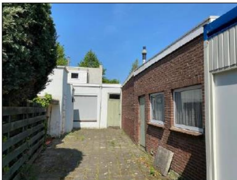
Achterzijde huidige bebouwing
