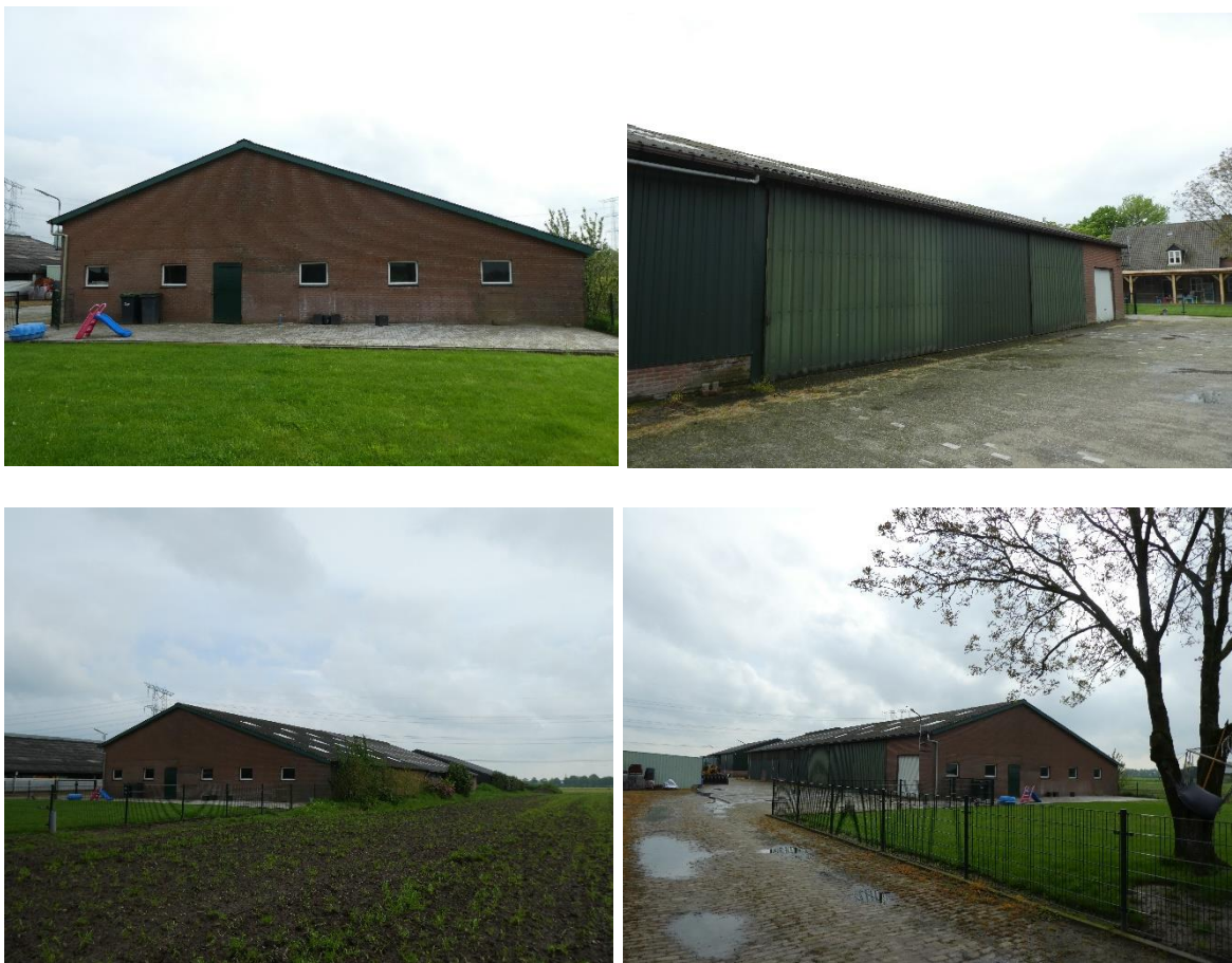
Afbeelding 3 t/m 6: Bestaande te verbouwen bebouwing. Bron: BNL advies. Datum: 12-05-2023
