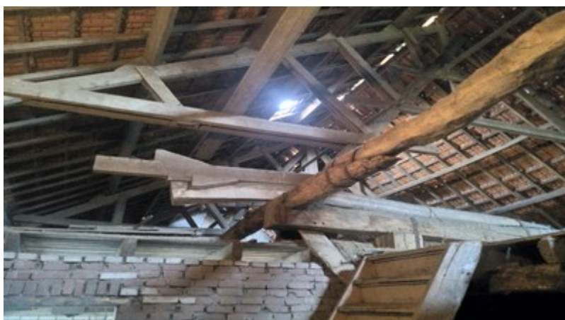
Binnenzijde van de te renoveren schuur met houten draagbalkconstructie. Foto: M. van der Neut | Ecoresult B.V.
