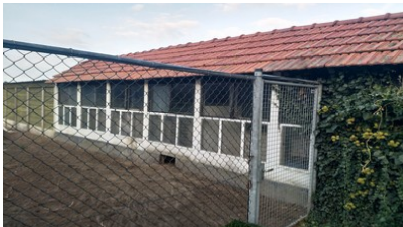
Te slopen gebouw momenteel in gebruik als verblijfplaats voor walibi's. Foto: M. van der Neut | Ecoresult B.V.
