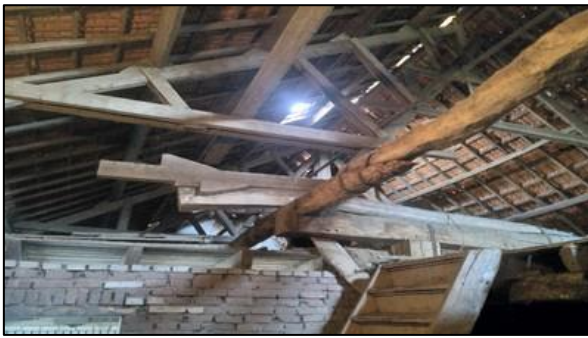
Figuur 5. Binnenzijde van de te renoveren schuur met houten draagbalkconstructie. Foto: M. van der Neut | Ecoresult B.V.
