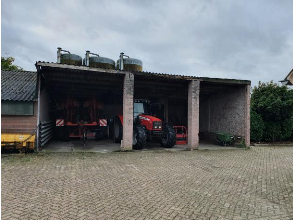
De te slopen werktuigenschuur en zicht op het achtererf.
