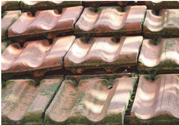
Foto 26: Broekzijde: Detail van het dak, Broekzijde 11
