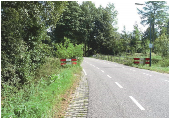
Foto 18: Broekzijde: Zicht op de wegversmalling bij de brug over de Reusel
