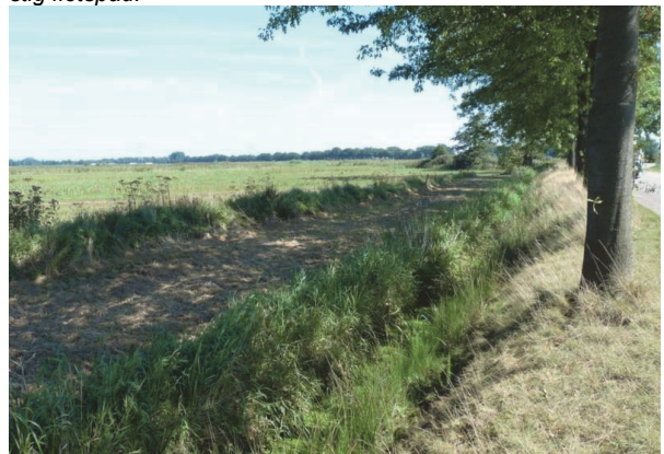
Foto 12: Heizenschedijk. Deel van het fietspad waar al een talud voor ligt. Foto genomen vanaf de weg, richting het noordoosten
