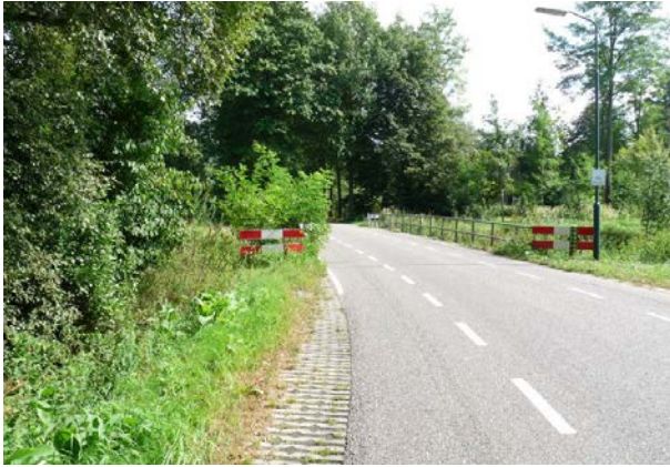
locatie van de brug met links de te verwijderen bosschages.
