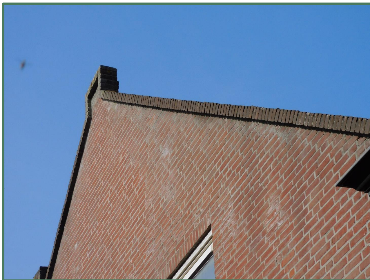
Gesloten muur aan oostgevel welke hoger is dan het dak.
