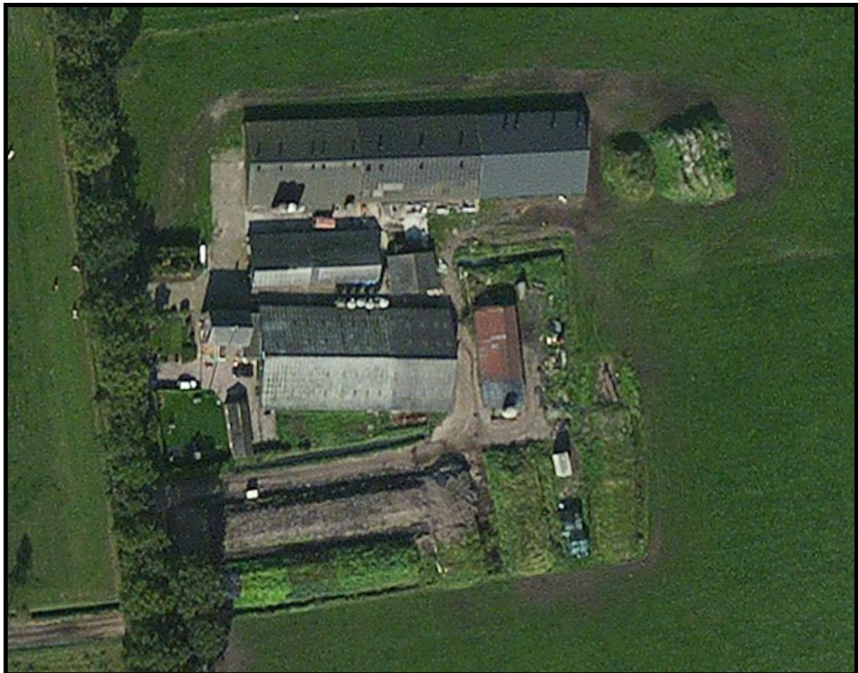
Luchtfoto huidige situatie.
