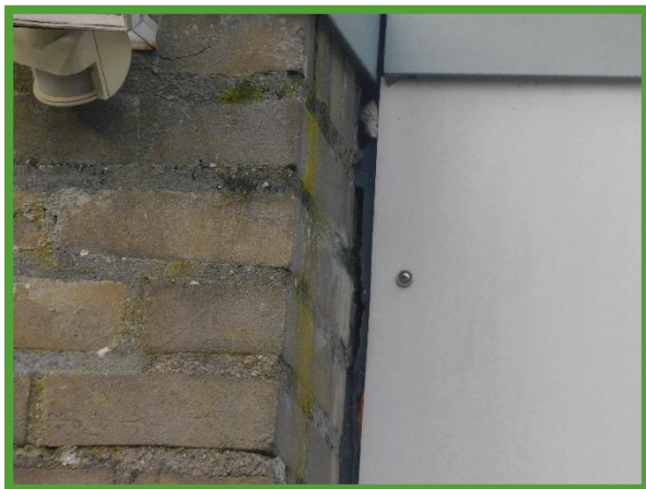
Ruimte naast boeiboord en open stootvoeg
