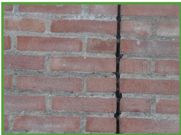
Dilatatievoeg en open stootvoegen
