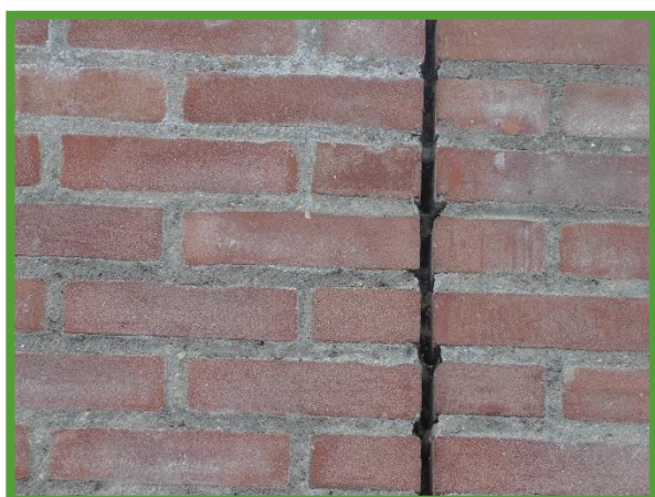
Dilatatievoeg en open stootvoegen
