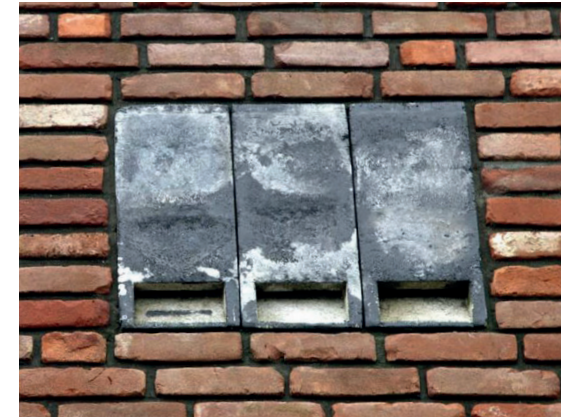
Voorbeeld van ingebouwde voorzieningen voor huismussen, gierzwaluwen en verschillende soorten vleermuizen in een natuurvriendelijk landschap.
