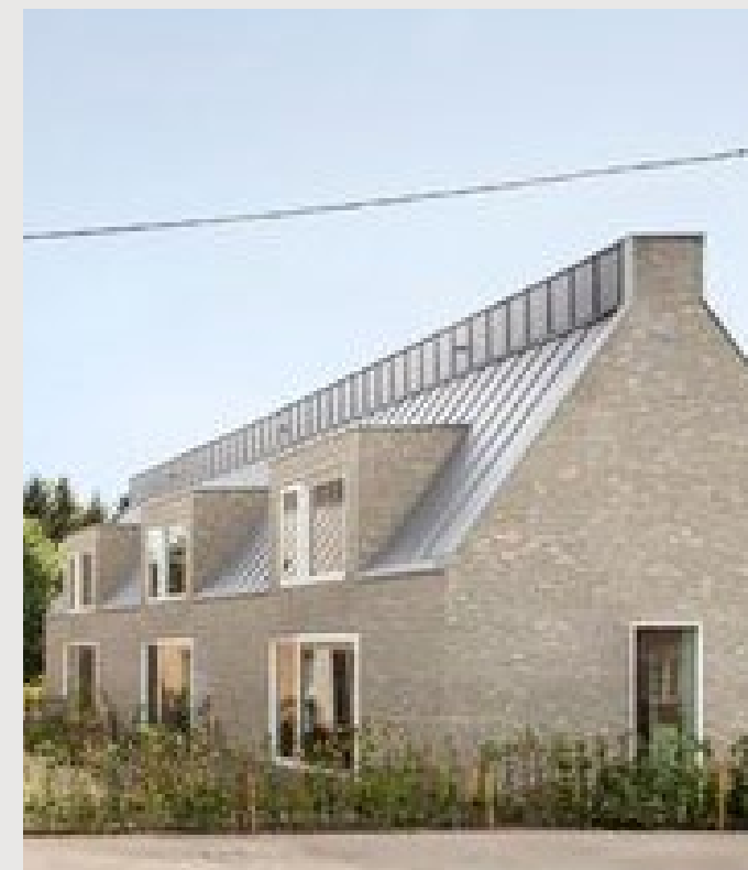
DAKKAPEL ONDERDEEL VAN DE GEVEL
