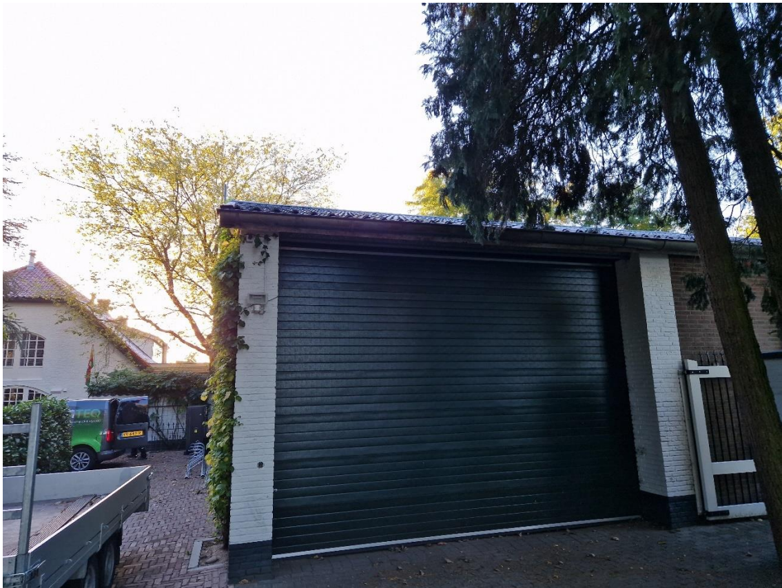
Foto 7. Westzijde van de schuur
