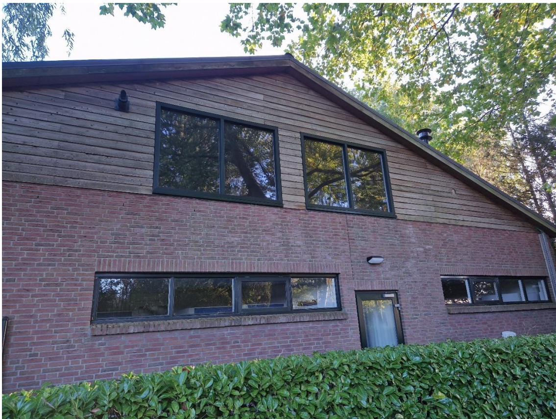
Foto 8. Zuidzijde van de schuur
