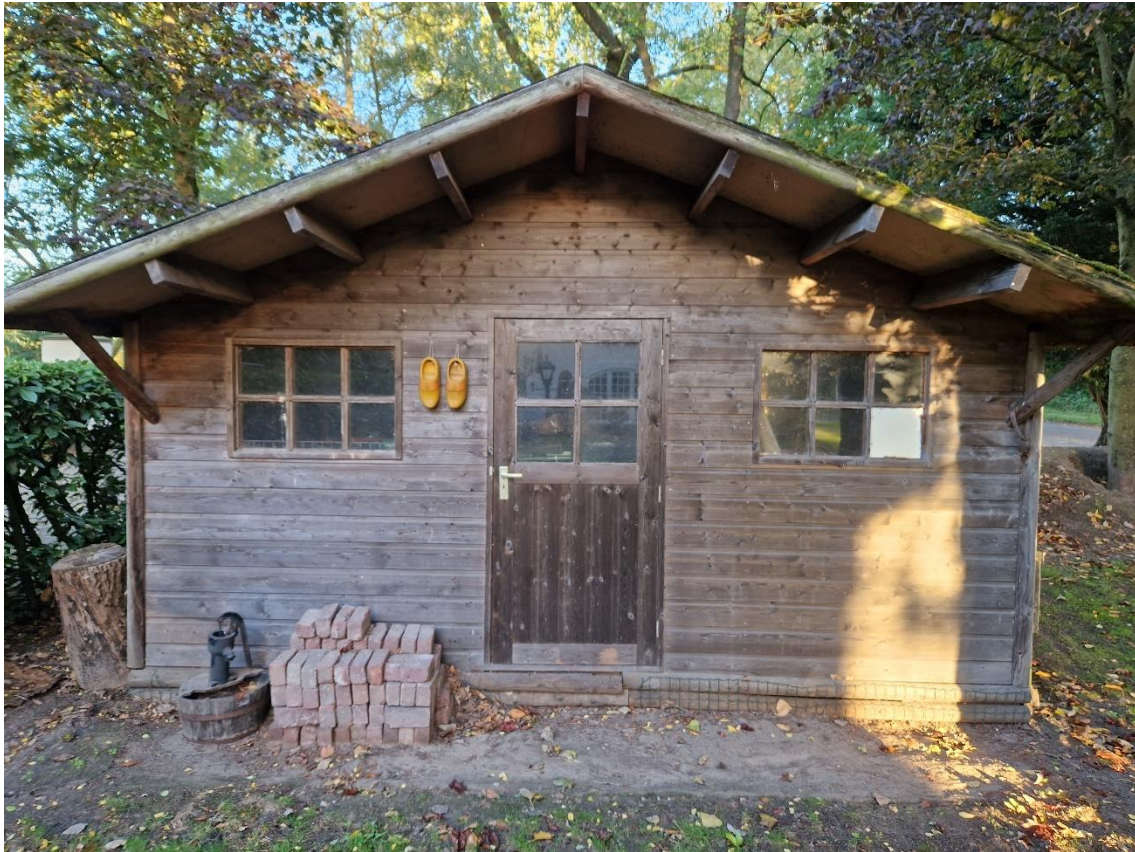
Foto 5. Te slopen opslaghek ten behoeve van de wadi
