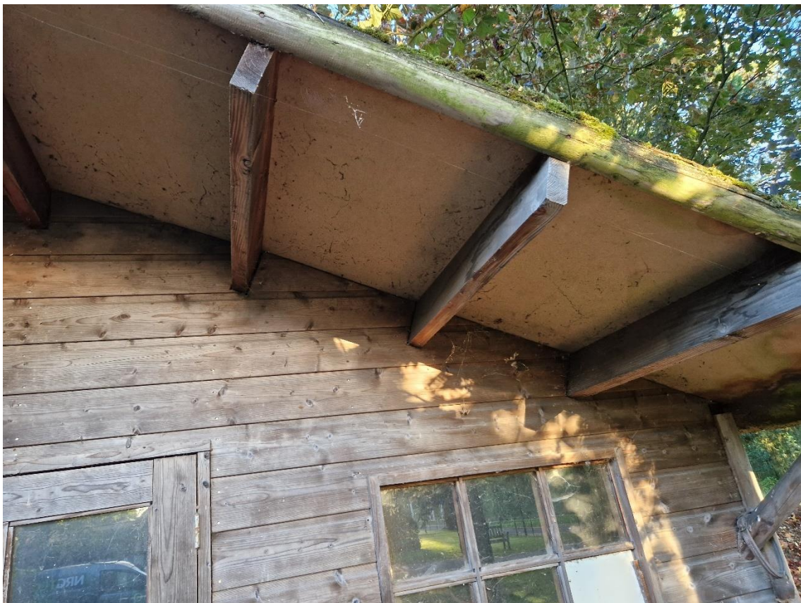
Foto 6. Dak aangesloten aan de muren van de te slopen opslaghek
