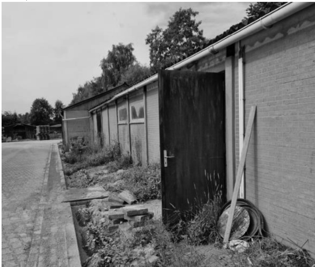
Te slopen oude schuur:
