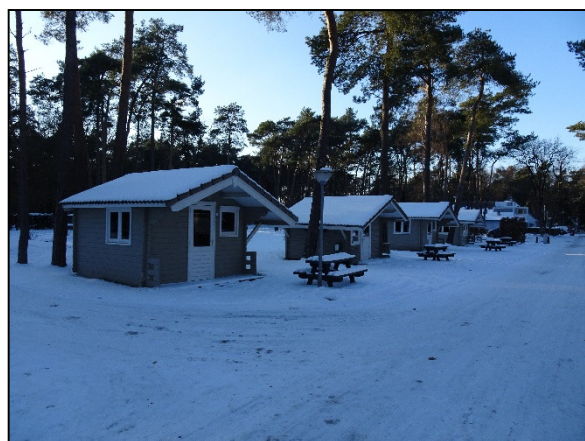
Figuur 13. Blokhutten met een dakpannen dak op de onderzoekslocatie welke geschikt zijn als verblijfplaats voor vleermuizen.
