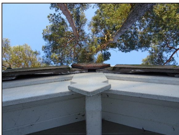
Figuur 12. Ruimte langs dakranden geeft toegang tot ruimte onder de dakpannen.
