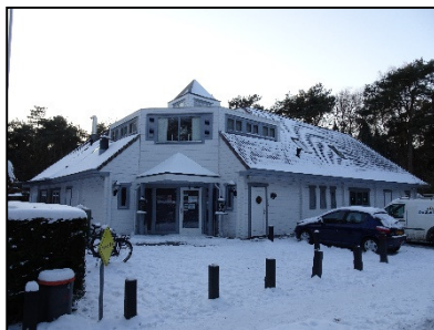
Figuur 3. Receptiegebouw op de onderzoekslocatie.
