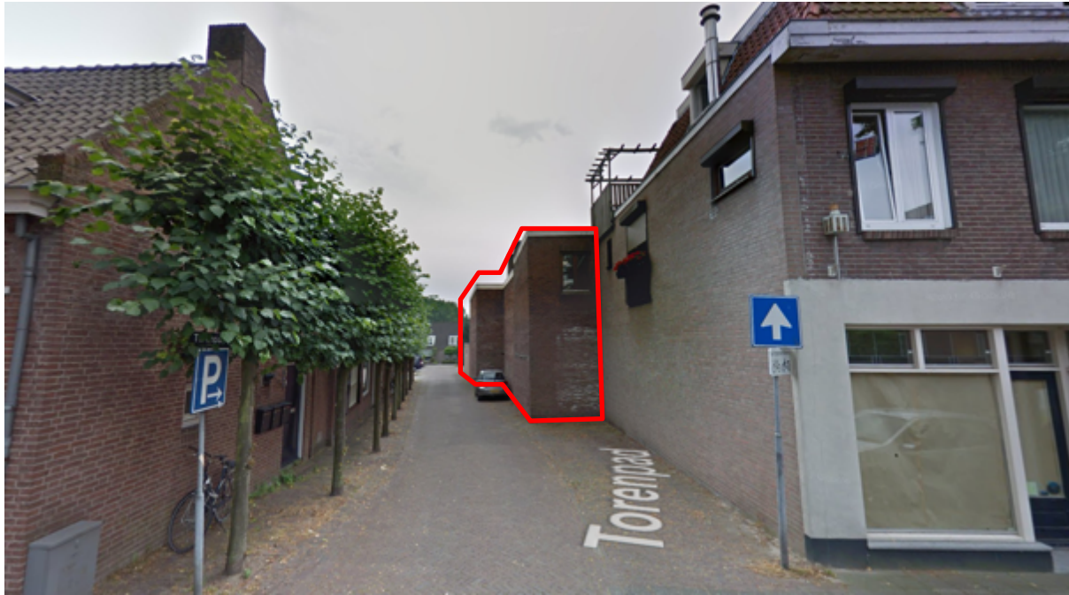
Foto Torenpad gezien vanaf de Kerkstraat. Bron: Google.nl
