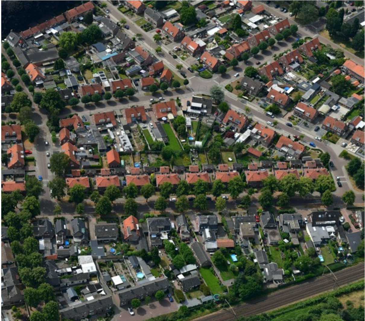
Foto met de ligging van de negen bouwvolumes aan de Tilburgseweg.
