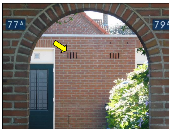
Figuur 12. Geschikte toegangsmogelijkheden voor vleermuizen.
