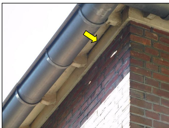
Figuur 11. Geschikte toegangsmogelijkheden voor vleermuizen.
