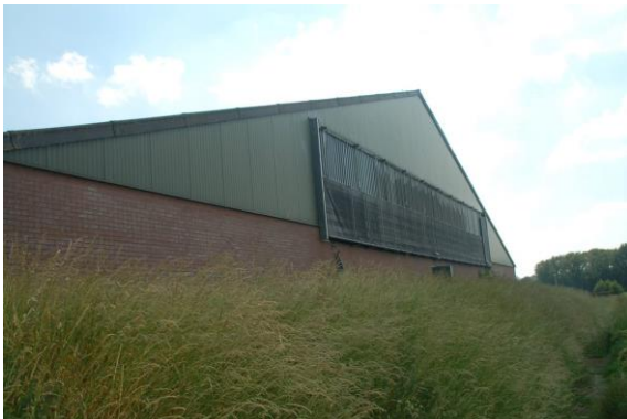
Achterzijde aanbouw stal met afgesloten luchtinlaat
