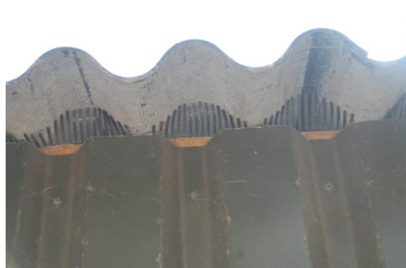
Openingen afgedekt met vogelschroot
