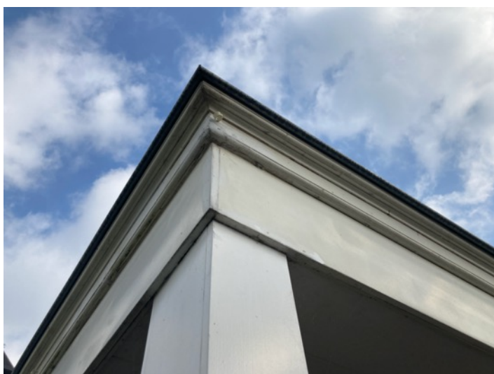
Kenmerkende afwerking van carport, kieren en gaten ontbreken.
