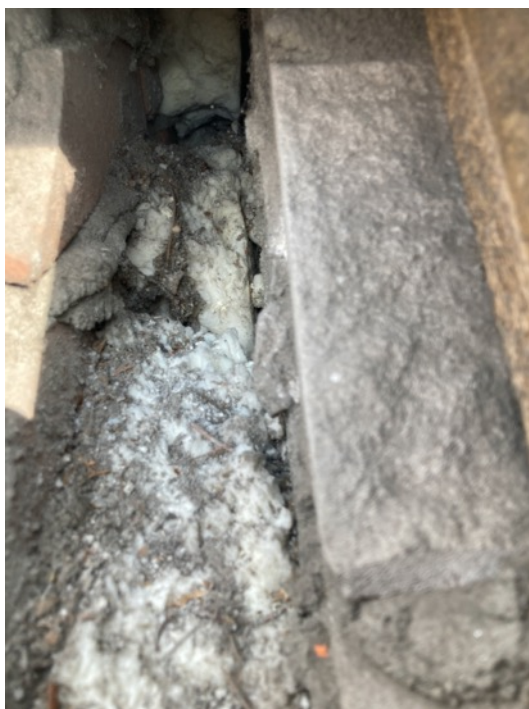
Bovenaanzicht van de spouwmuur. De isolatie is hier goed te zien. Ruimte voor vleermuizen ontbreekt.
