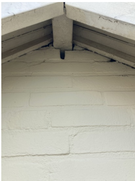
Opening in de punt van de westgevel van het bijgebouw. In de opening is enkel spinrag aangetroffen. De opening bevindt zich relatief laag boven het platte dak van de carport. Bovendien komt de opening uit in de geïsoleerde spouw. Er is geen sprake van een vaste rust- of verblijfplaats van vleermuizen.
