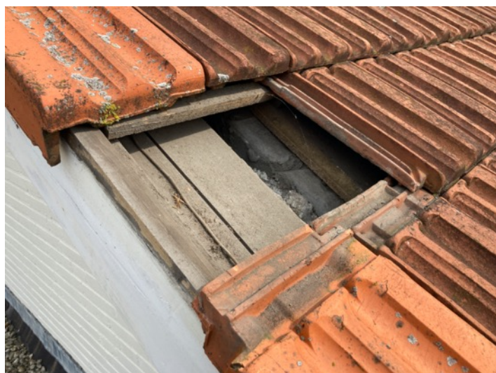
Enkele pannen van het bijgebouw zijn ten behoeve van de inspectie verwijderd om inzicht te verschaffen in de opbouw van het gebouw. Sporen ontbreken. De spouwmuur is geïsoleerd zoals op de volgende foto te zien is.
