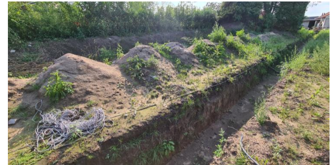
Figuur 6: Greppel langs zuidgrens perceel
