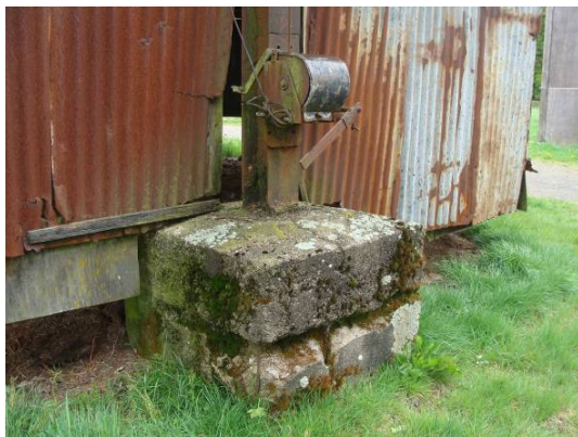
Foto links: betonnen voet met hijsmechanisme aan de onderzijde van een roede van de hooiberg.
