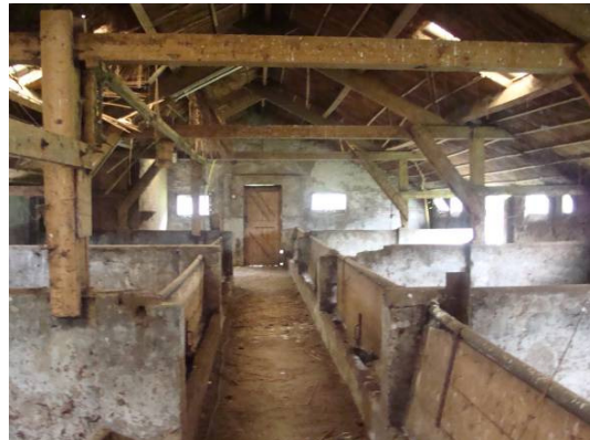
Foto rechts: de varkensschuur van binnen: houten draagconstructie nog nagenoeg compleet en gaaf.
