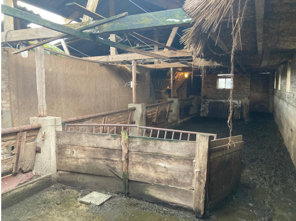
• Afbeelding 12: binnenzijde leegstaande varkensstal
