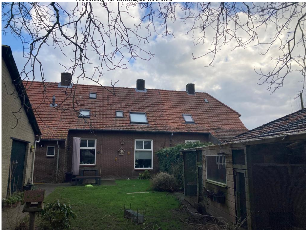
• Afbeelding 18: achterzijde woonhuis
