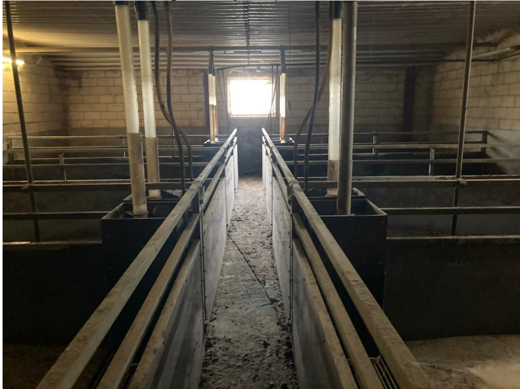
• Afbeelding 24: binnenzijde te slopen varkensstal
