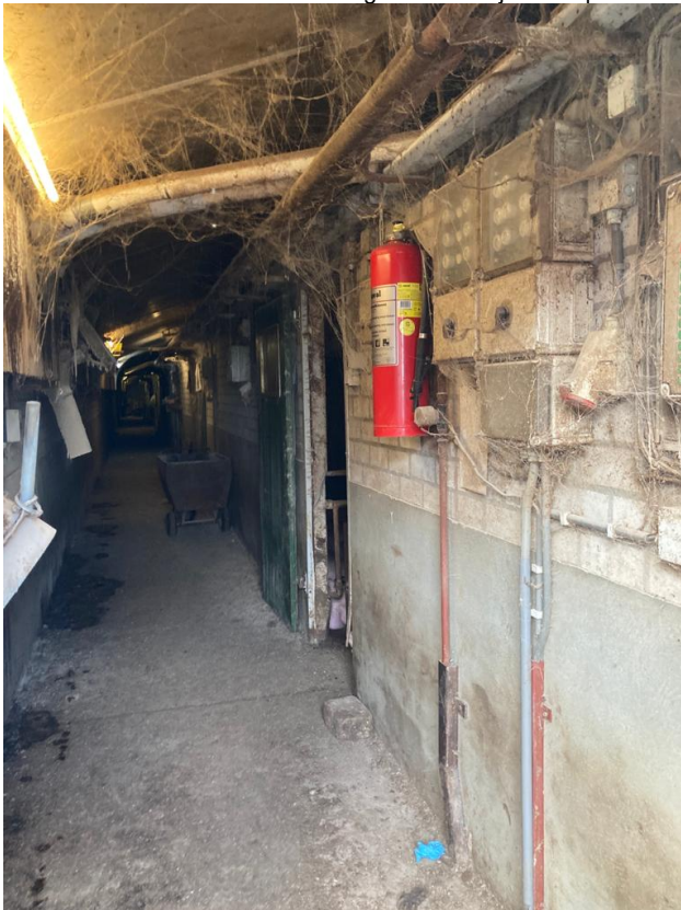
• Afbeelding 25: binnenzijde te slopen varkensstal
