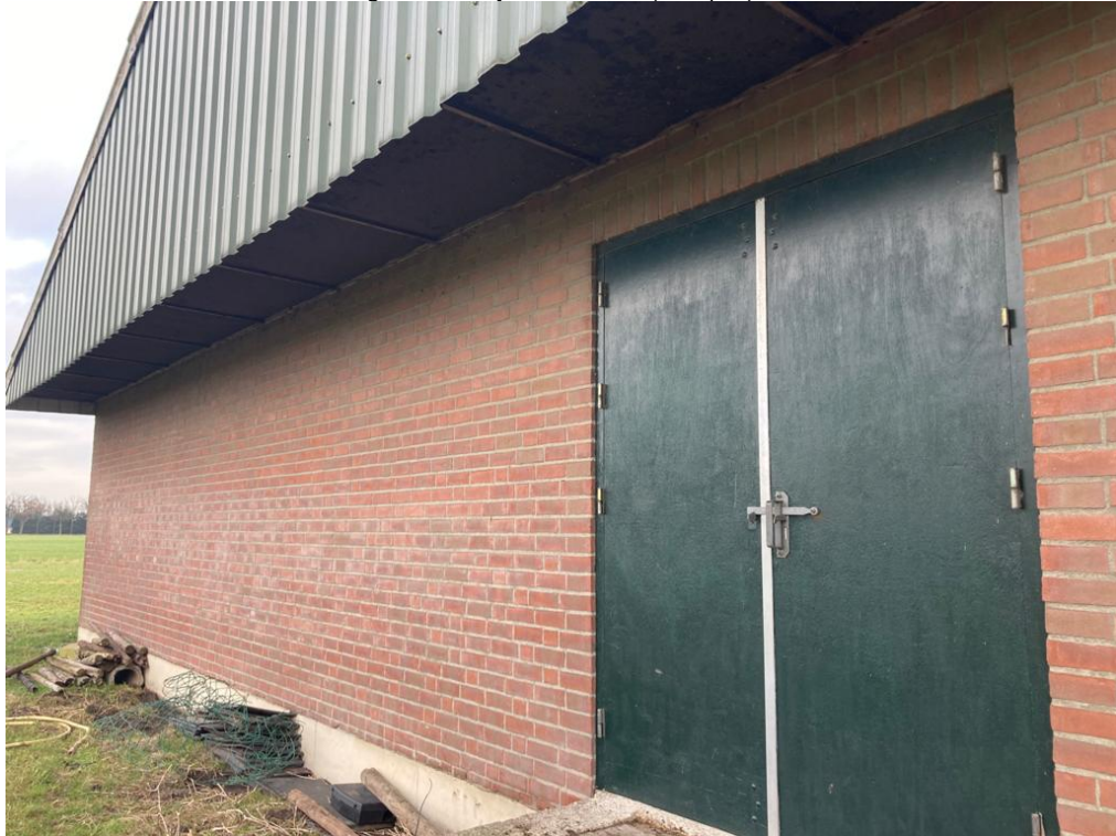
• Afbeelding 22: achterzijde varkensstal (te slopen)
