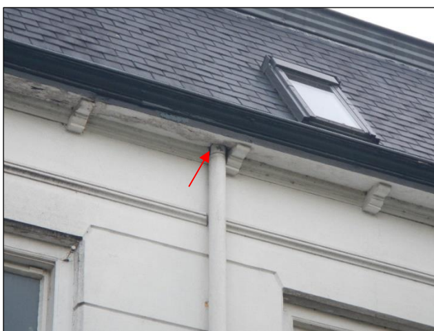
Figuur 7. Invliegplek gewone dwergvleermuis aan de achterzijde van de pastorie.
