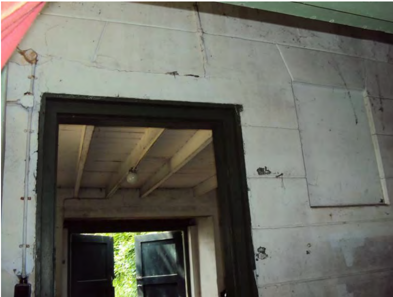
23. Voormalige achtergevel van de 'waschruiimte'; de patronen in het pleisterwerk geven aan dat hier oorspronkelijk twee kleine vensters hebben gezeten; de later aangebrachte deur is niet oorspronkelijk.
