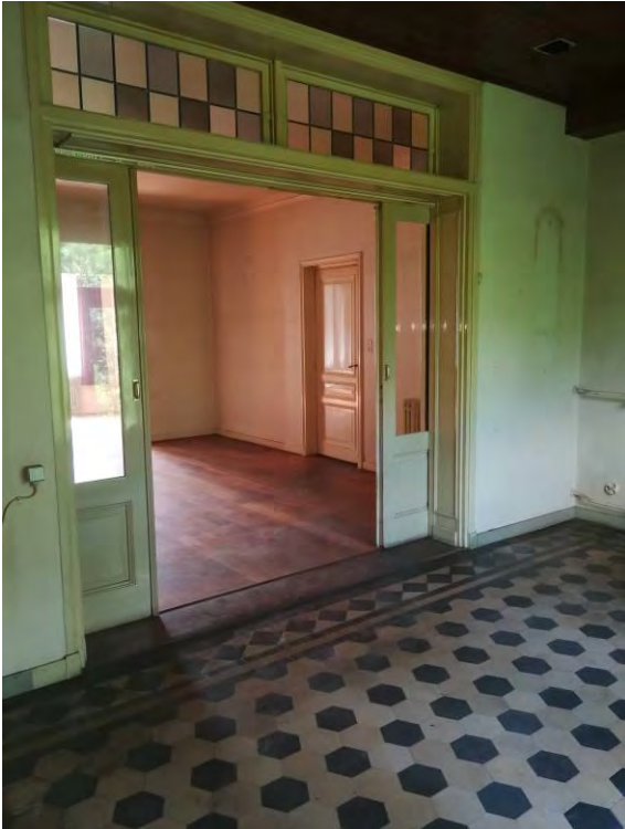
40. Serre met tegelvloer uit 1895-1905
