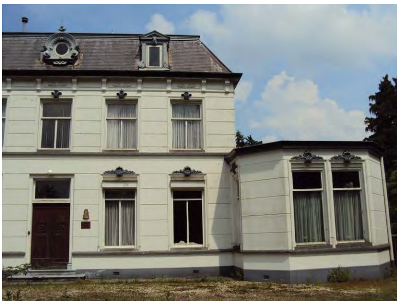
26. Voorgevel met aansluiting op 'vergaderzaal'.
