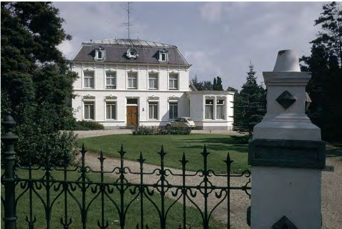
15. Foto 1975; De zinken dakbanen van het liggende dakvlak zijn duidelijk zichtbaar; De vensters op de begane grond zijn voorzien van rolluiken; Het leeuwje op de poortpenant is nog niet aanwezig; De vlaggemast in de voortuin is nog niet aanwezig.
