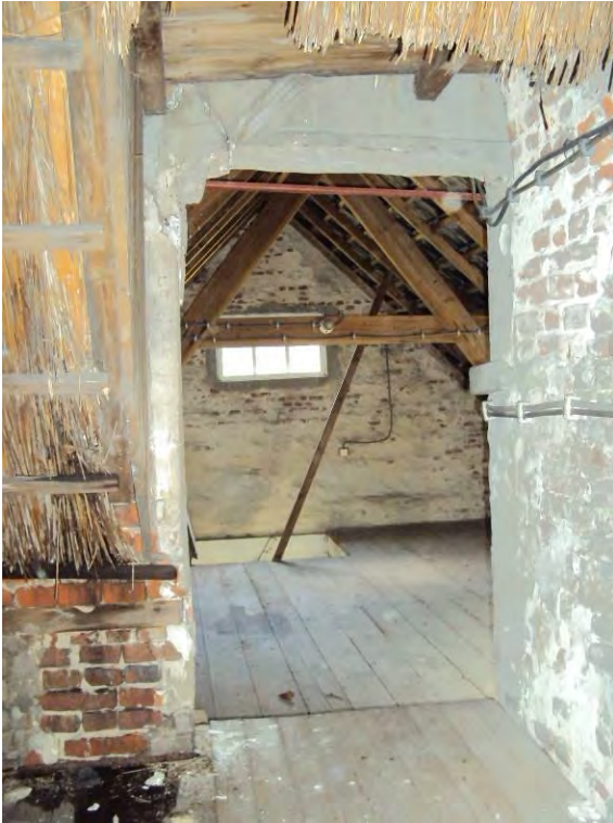
20. Later aangebrachte verbinding tussen zolder van linkerzijvleugel en uitbreiding 1895-1905; restanten van ongesaust gevelpleisterwerk. Daarachter kapconstructie van de uitbreiding 'waschruijnte'.
