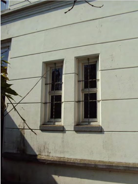
25. Achtergevel hoofdbouw; de contouren van één groter venster zijn nog vaag zichtbaar in krimpseurtjes in het gevelpleisterwerk.
