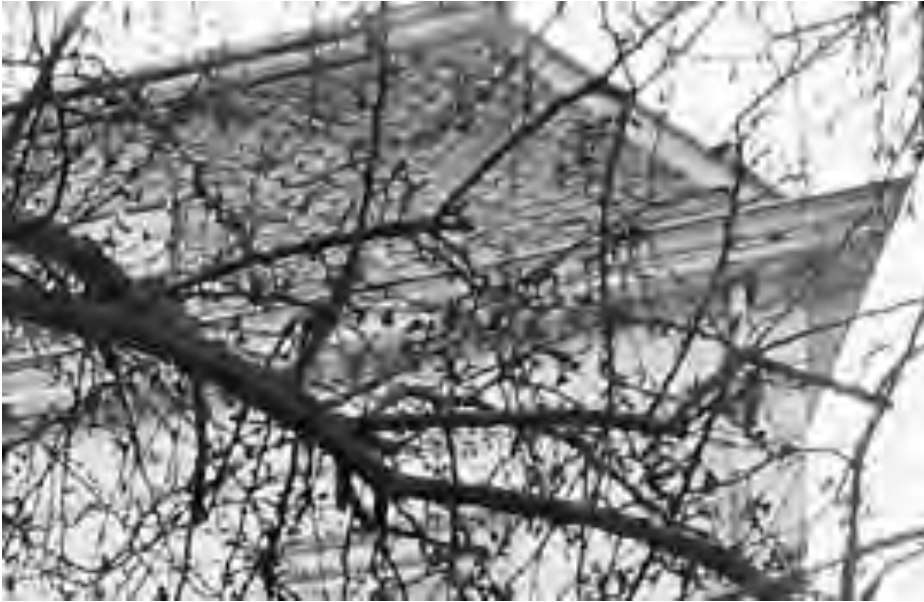
Detail van foto uit 1974; Hier is duidelijk te zien dat op dit dakvlak leien met afgeronde of lamme oren lagen.
