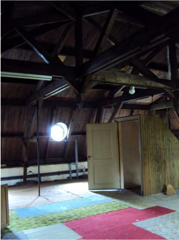
22. Kapconstructie hoofdbouw; aangebracht 1895-1905; samengestelde grenen spanten (190x90mm) met dubbele koningstijl, muurplaat, gordingen, randbalk en staand dakbeschot (185x22mm). De spanten zijn voorzien van telmerken. Kapconstructie is volledig gaaf.
