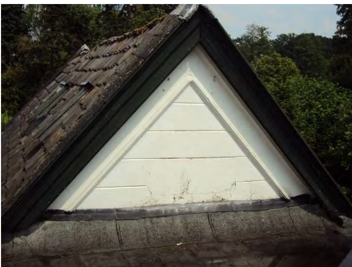
29. Topgevel rechterzijvleugel boven platdak 'vergaderzaal'; in het pleisterwerk zijn sporen zichtbaar van een gevelopening vlak boven de huidige dakbedekking van het platdak.
