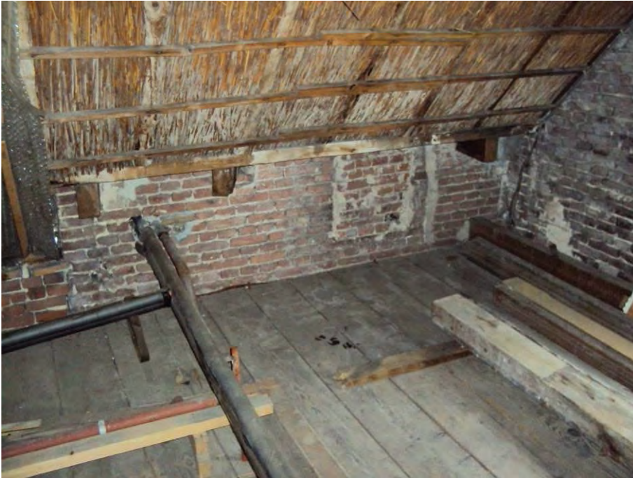
16. Zolder van de linkerzijvleugel gezien naar gevel van de hoofdbouw; afwijkend metselwerk tussen de voorgevel (rechts te zien) en zijgevel (links te zien) van de linkerzijvleugel en hoofdbouw (middendeel).
