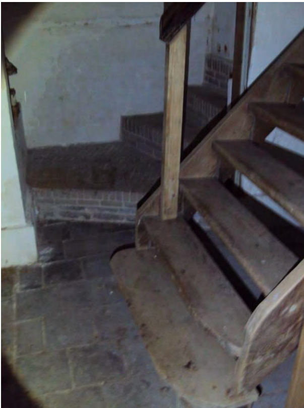
17. Kelder hoofdbouw; doodlopende gemetselde trap en houten trap door later aangebrachte sparing in het gemetselde gewelf.
