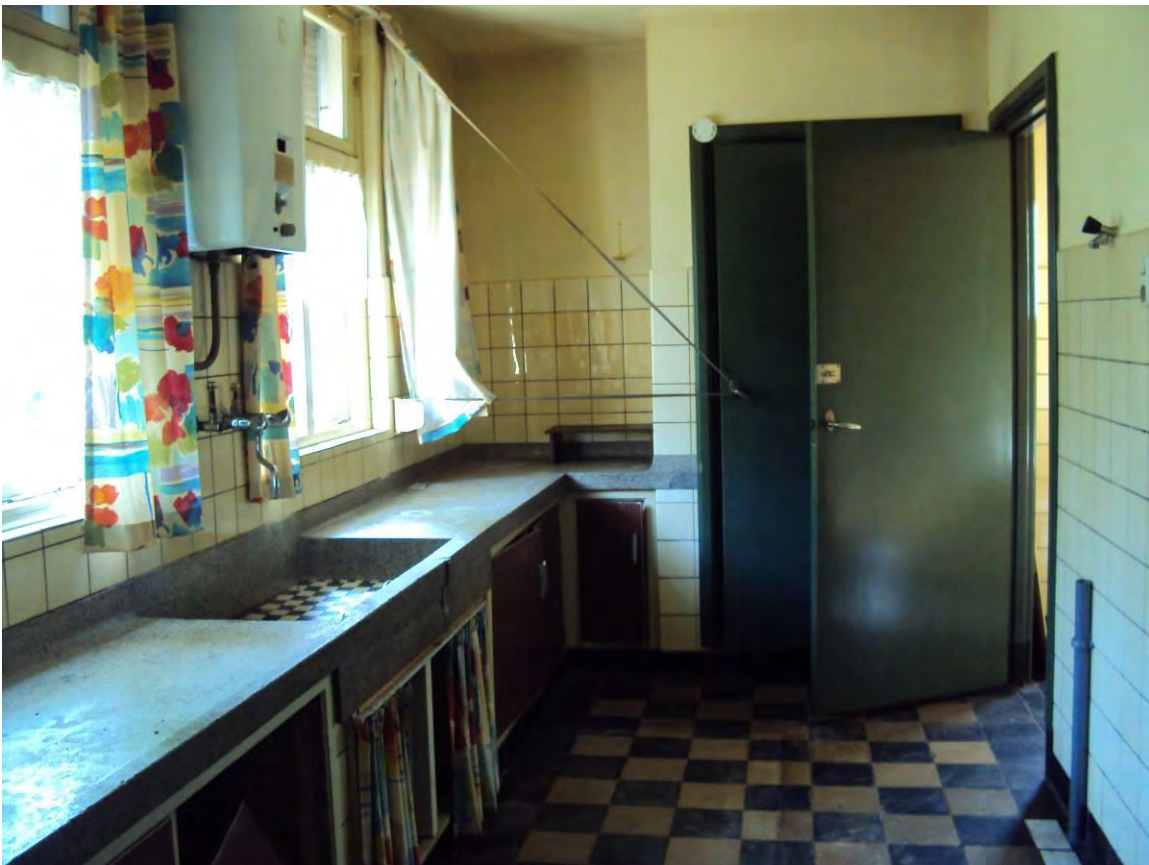
42. Linkerzijvleugel; bijkeuken vloer uit periode 1895-1905; granito aanrechtblad van later datum
