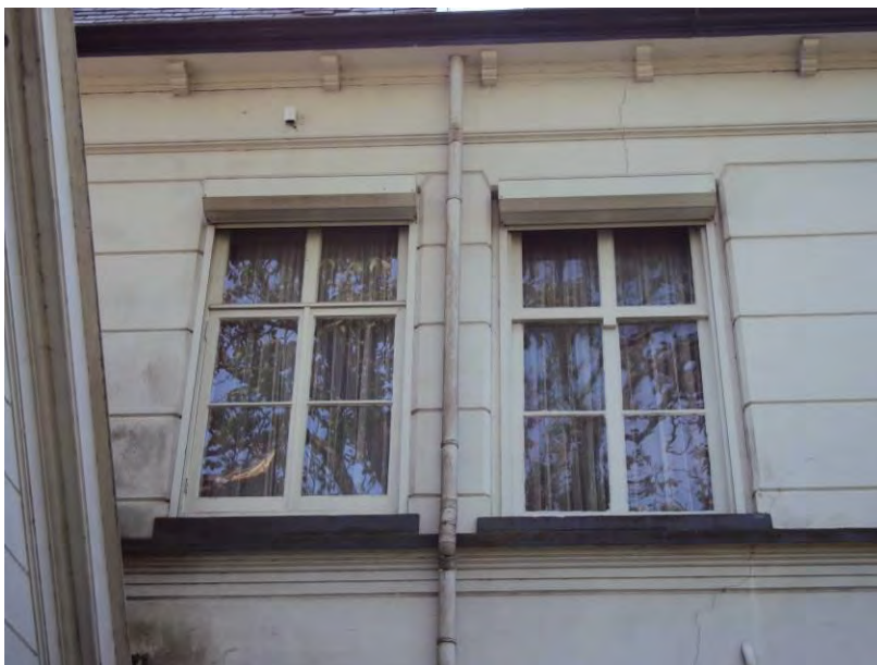
30. Linkerzijgevel hoofdbouw; het linkervenster is later bijgemaakt
