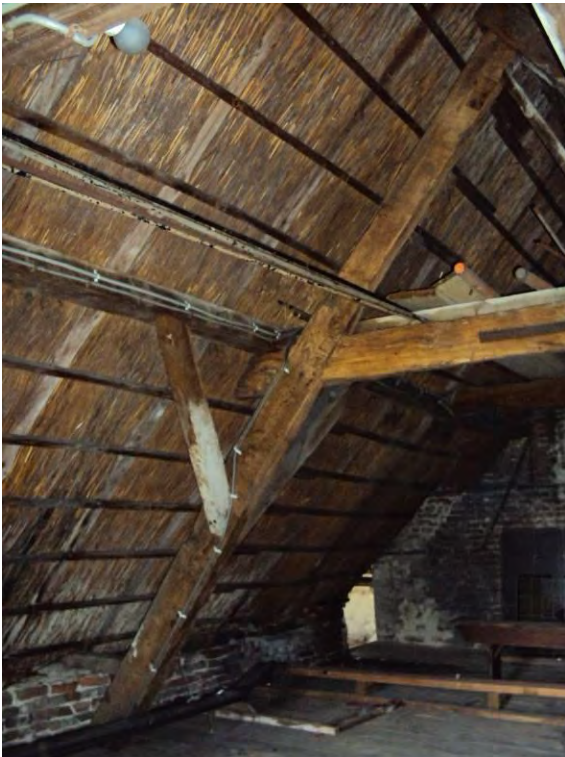
21. Kapconstructie linkerzijvleugel boven keuken; steekspant met wurmt en geschaafde rondhouten sporen waartussen spreidse van riet.
