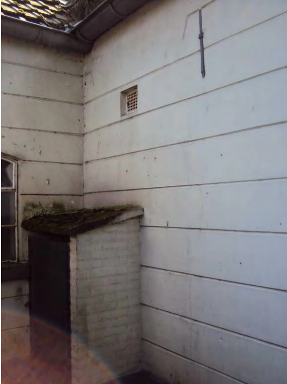
24. Voormalige dienstingang aan de zijgevel van de linkerzijvleugel; sporen in de gevelbepleistering aan de bovenzijde verraden de locatie waar voorheen een gevelopening heeft gezeten.
