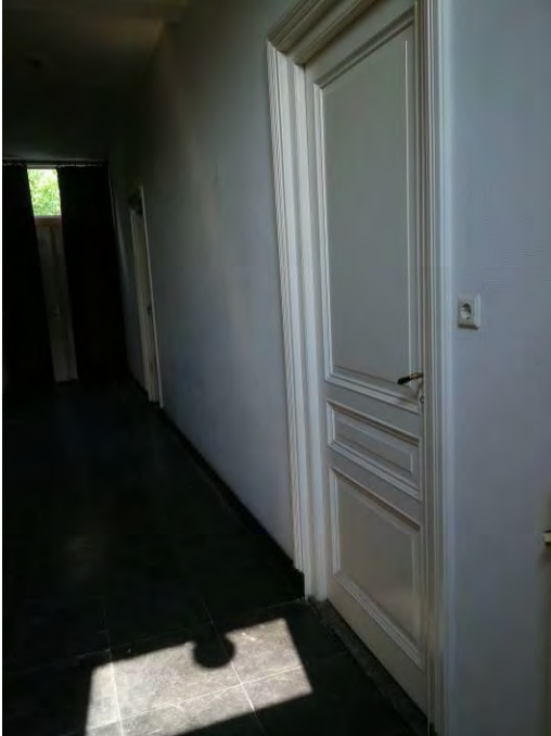
36. Paneeldeur met profilering uit 1840
