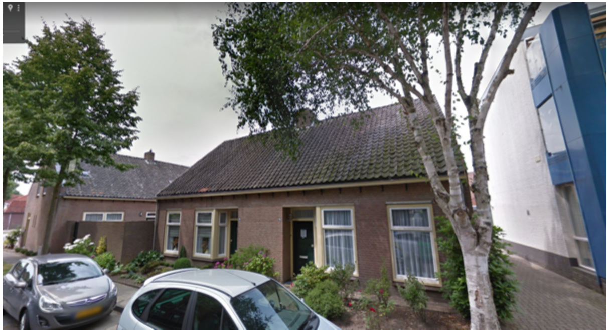
Foto bestaande situatie aan de zijde van de Poirtersstraat. Bron: google.nl
