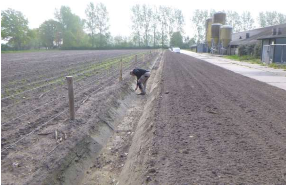
Figuur 20: Inspectie van het profiel van de nieuw gegraven sloot.
