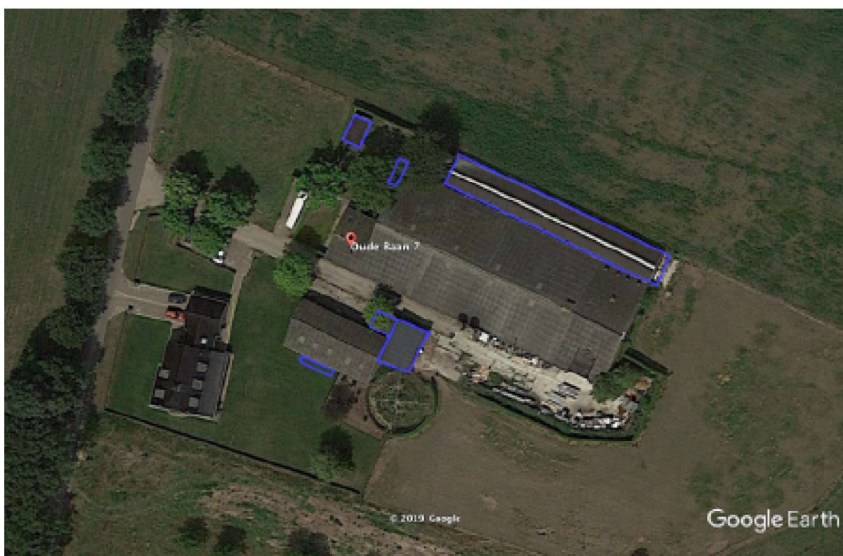
Afbeelding 1: ligging plangebied en te slopen bebouwing in blauw (bron: Google Earth)
