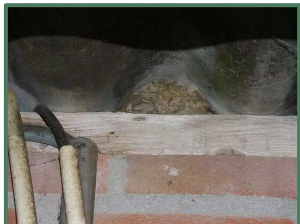
Afgesloten dakranden met muurplaat
