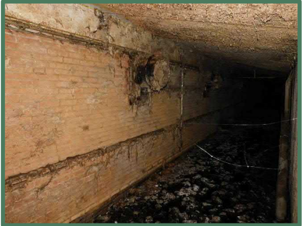
Overzicht binnenzijde luchtafzuiging
