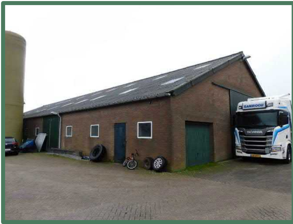
Overzicht te behouden loods
