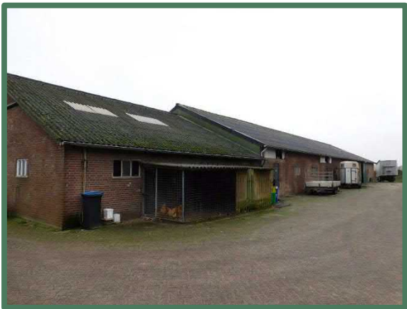
Overzicht te slopen loods
