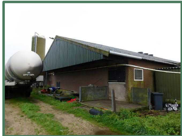
Overzicht noordelijke luchtinlaat
