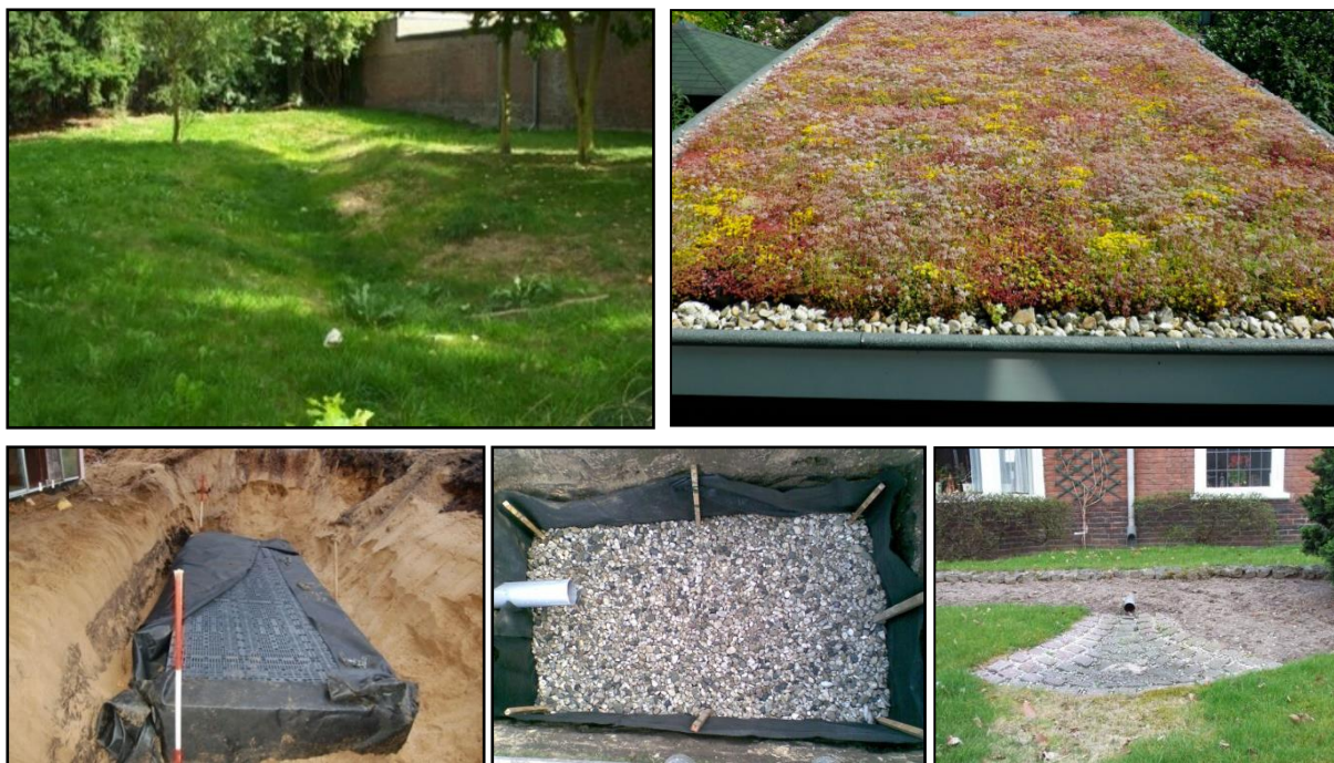
Figuur 26: Voorbeelden infiltratievoorzieningen
