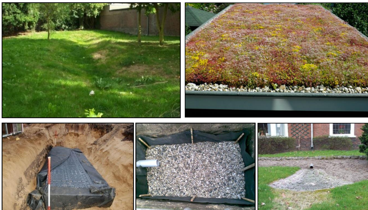
Figuur 25: Voorbeelden infiltratievoorzieningen
