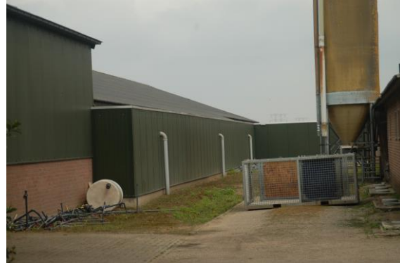
Zijgevel stal 2 met centrale luchtafvoer
