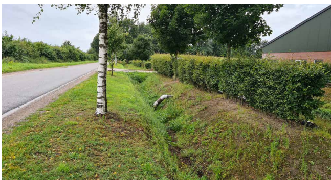
Figuur 7: Sloop langs de Molenakkerstraat, gekoppeld aan infiltratiebuffer.
