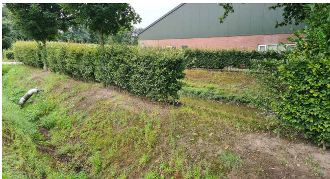
Figuur 6: Bestaande hemelwaterinfiltratiebuffer.
