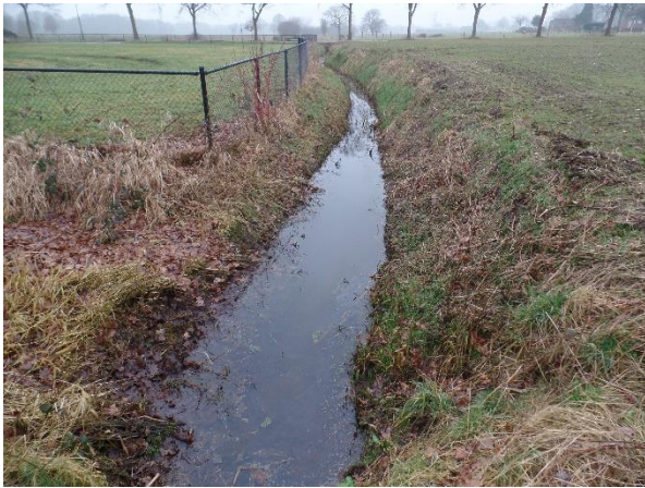
Fig.16. Centrale watergang west
