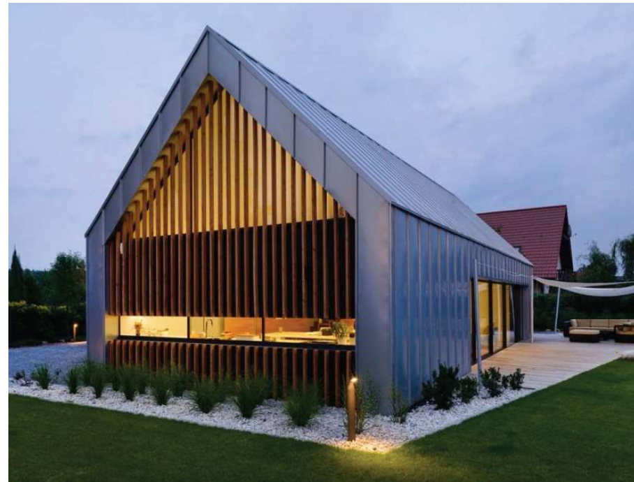
Achtergevel uitgevoerd in glas met louvres
