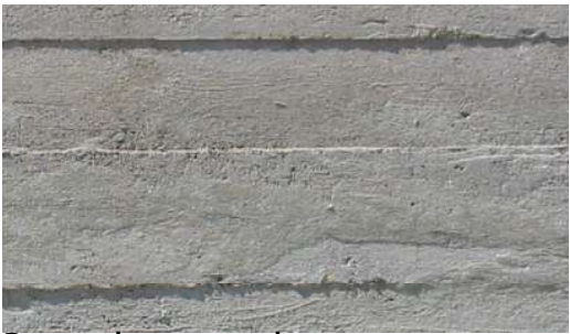
Beton brut met hout structuur
