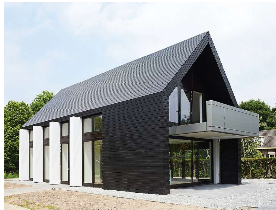
Bijgebouw uitgevoerd als schuur typologie
