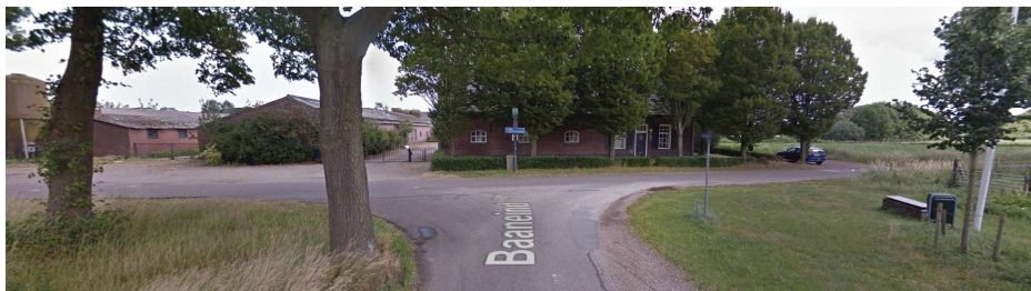
Langgevel boerderij aan T-splitsing, met metselwerk en pannendak
