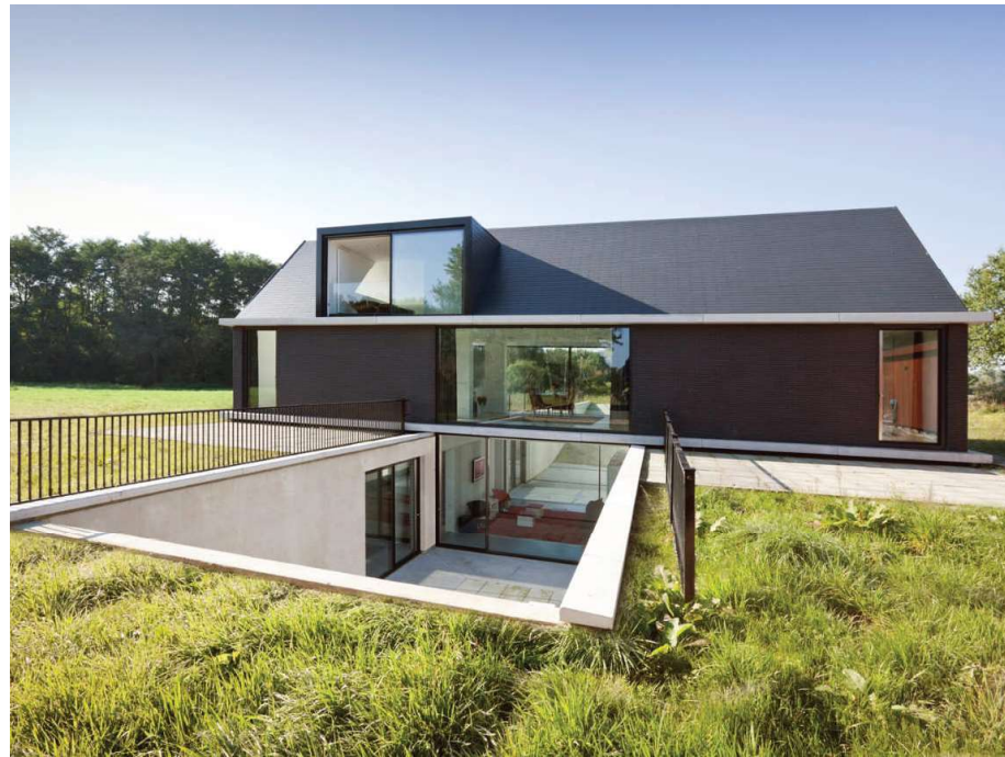
Plint loopt over in terras en naar kelder
