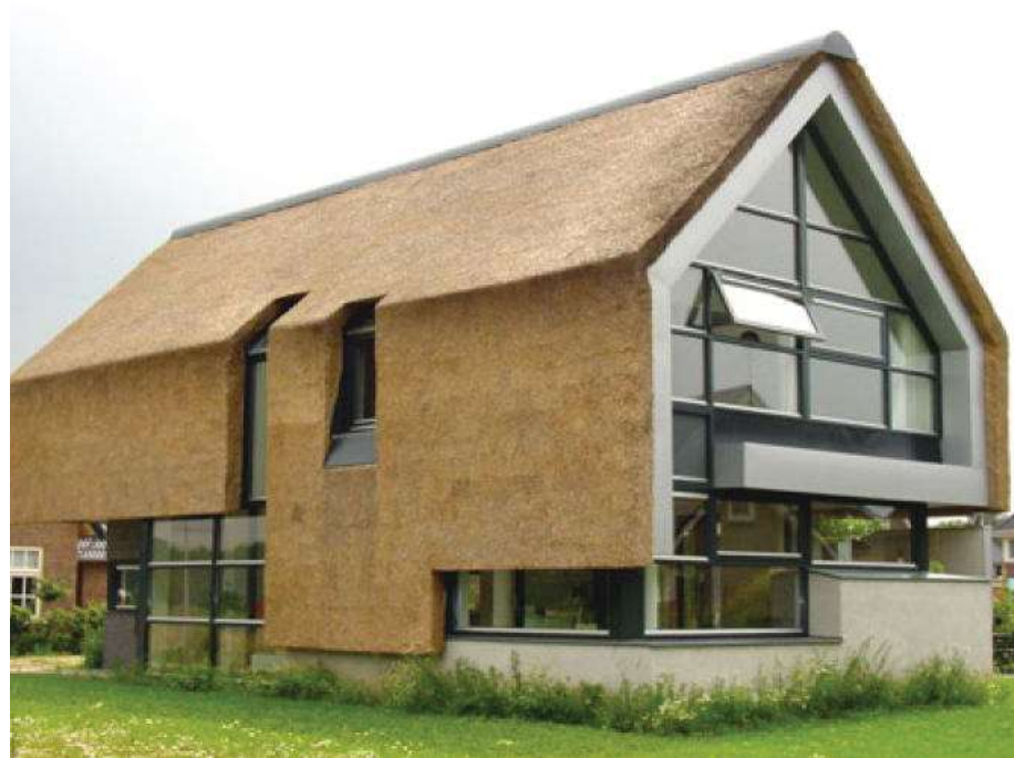
Riet loop over van dakbekleding in gevelbekleding
