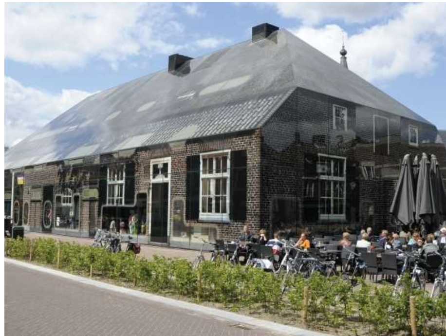
Langgevel vorm volledig uitgevoerd in glas
