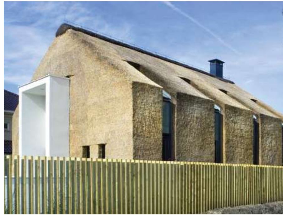
Dakbekleding loopt over in de gevelbekleding
