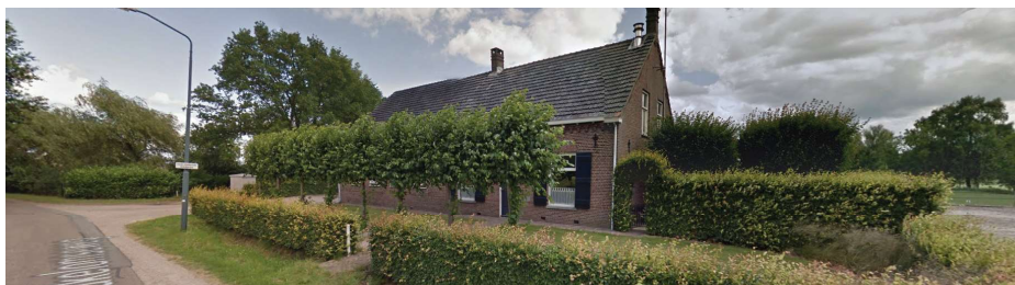
Langgevel boerderij uit metselwerk en pannendak.
