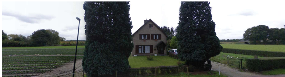
Traditionele bouw met metselwerk en pannendak
