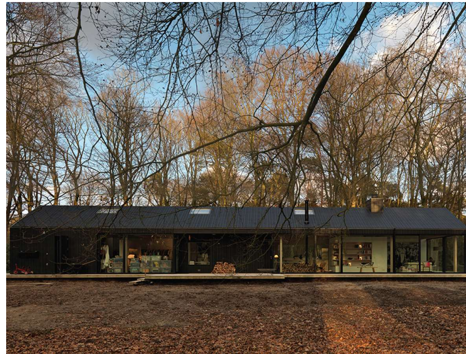
Achtergevel uitgevoerd in glas
