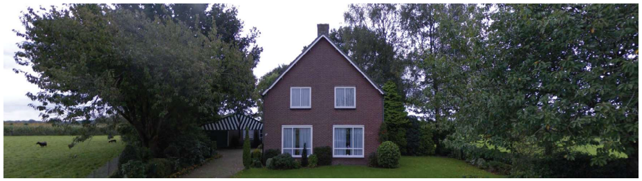
Traditionele bouw met metselwerk en pannendak
