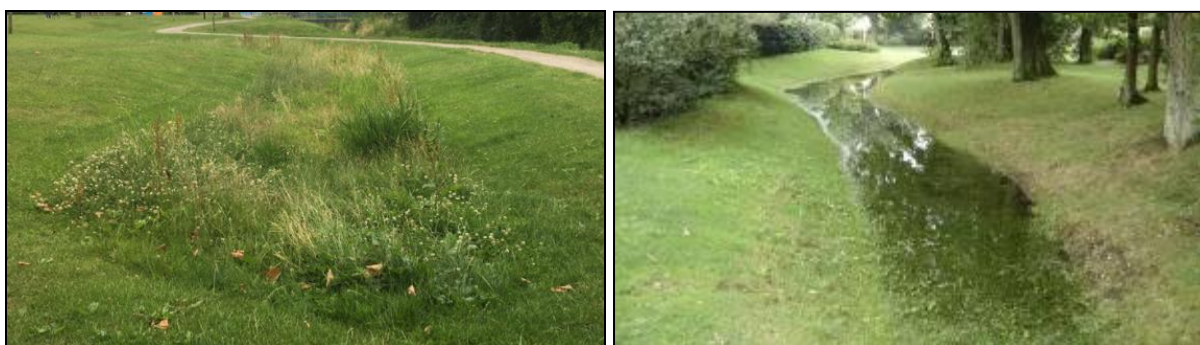
Figuur 6: Voorbeeld infiltratievoorziening (infiltratieveld of wadi)
