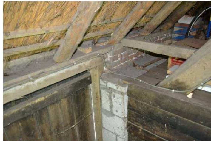
Geveldetail binnenzijde voorgevel met oorspronkelijk metselwerk met kalkvoeg, voorzetwand, muurplaat met spanten, sporen en rieten dakbedekking.
