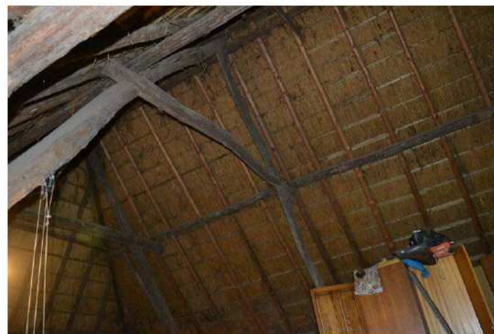
Gebintconstructie met houten spanten, gordingen en sporen en de rieten dakbedekking, vanaf de binnenzijde gezien.
