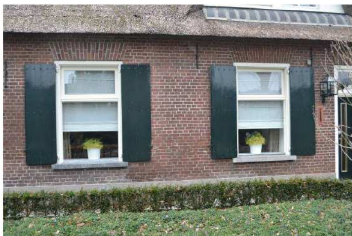
Twee huidige gevelopeningen links van de voordeur.
