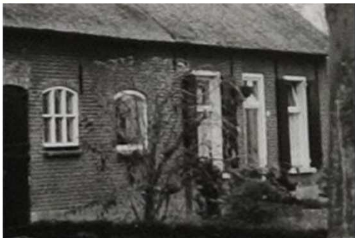
Foto (1981) met het vervangen stalraam links van de voordeur. Bron: BHIC
