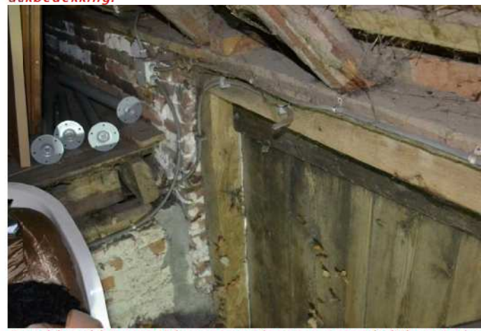
Geveldetail binnenzijde voorgevel met oorspronkelijk metselwerk met kalkvoeg, ter plaatse van het staldeurkozijn.
