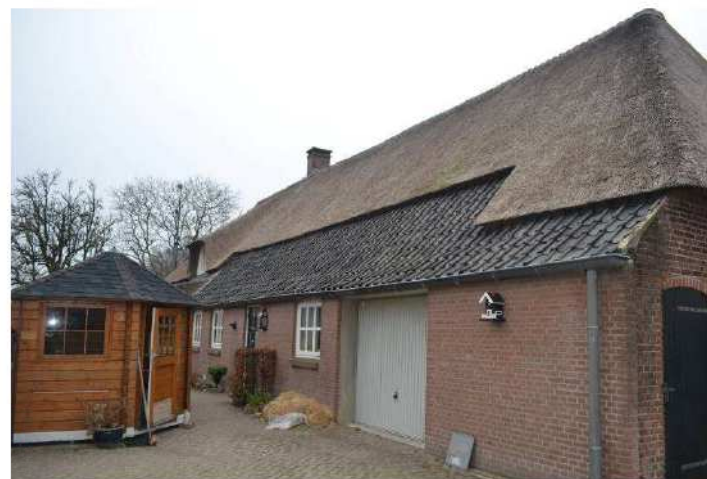
(Voormalig) bedrijfsgedeelte nieuwe achtergevel.
