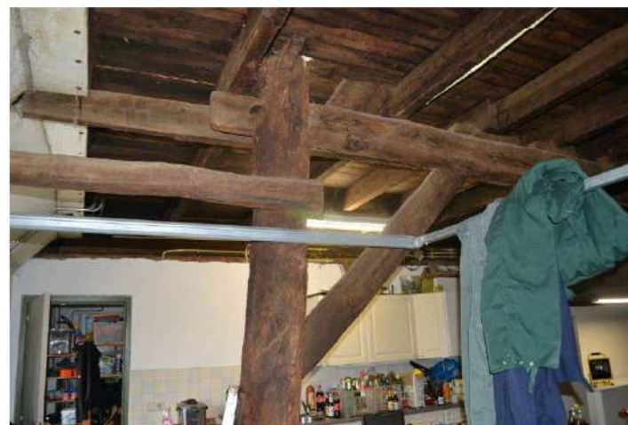
Gebintstijl aan achterzijde.
