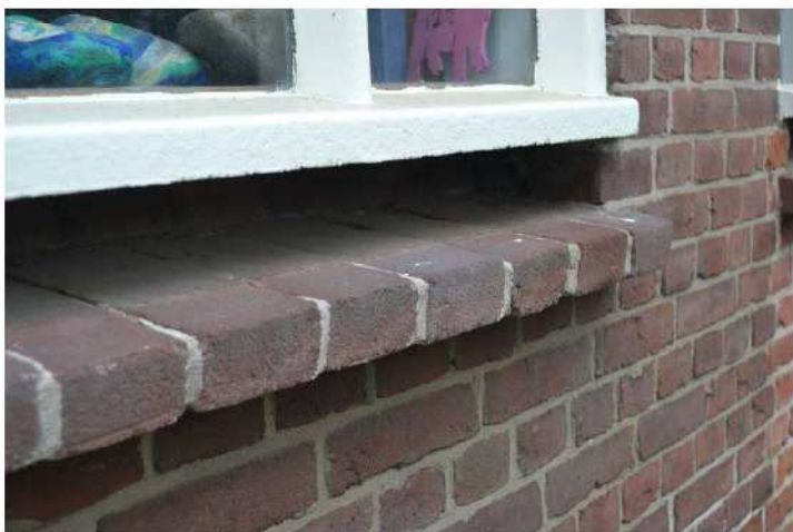
Opening onder stalraam.
