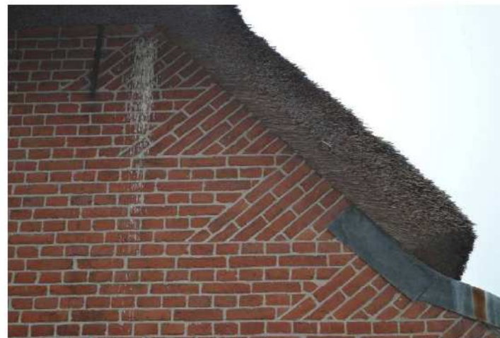
Boerenvlechting in het metselwerk.
