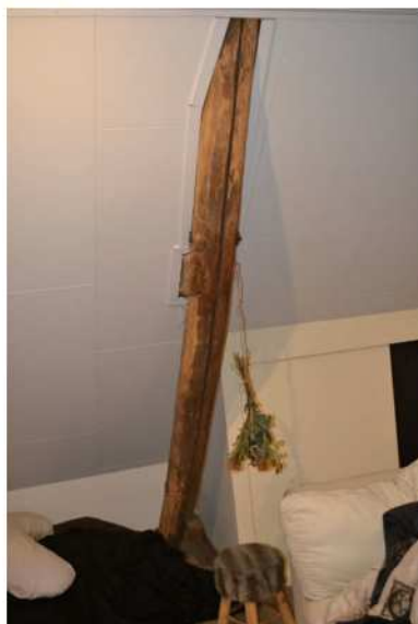
Gebintconstructie deels nog zichtbaar.
