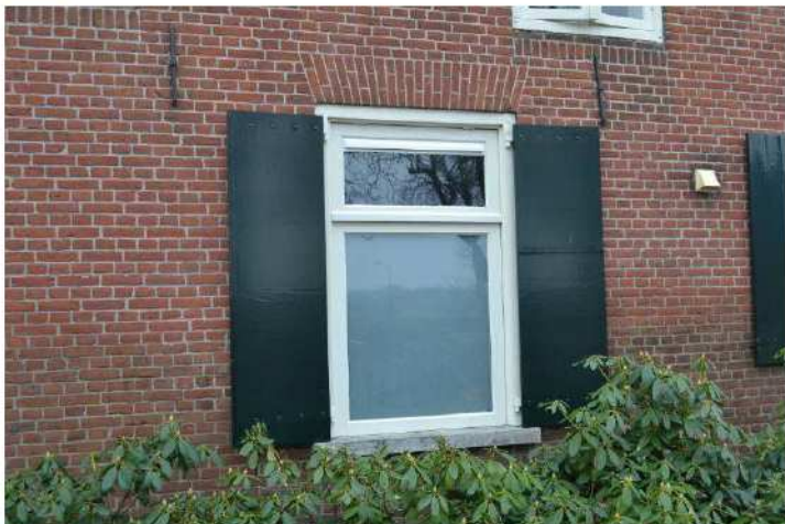
Gevelopening met buitenluiken.
