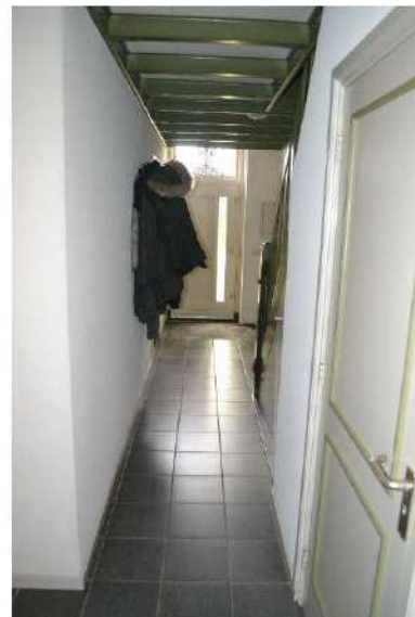
Gang naar voordeur met nieuwe vloer en plafond.
