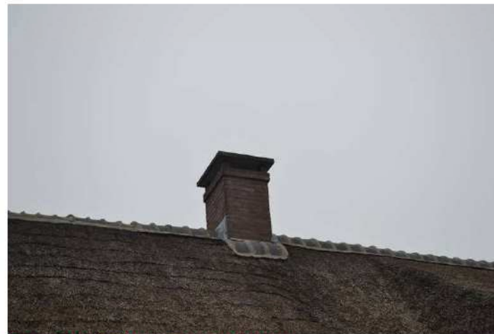
Schoorsteen met betonnen afdekplaat.
