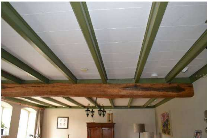
Bestaande ankerbalk met balklaag en nieuw plafond daartussen.
