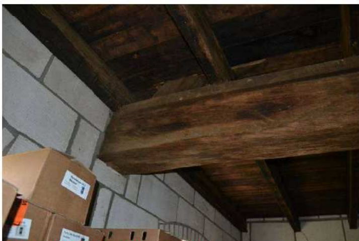
Ankerbalk in gevelmetselwerk opgelegd.
