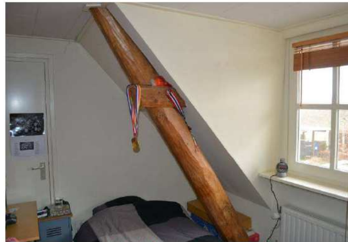
Afwerking binnenzijde met kapconstructie in zicht.
