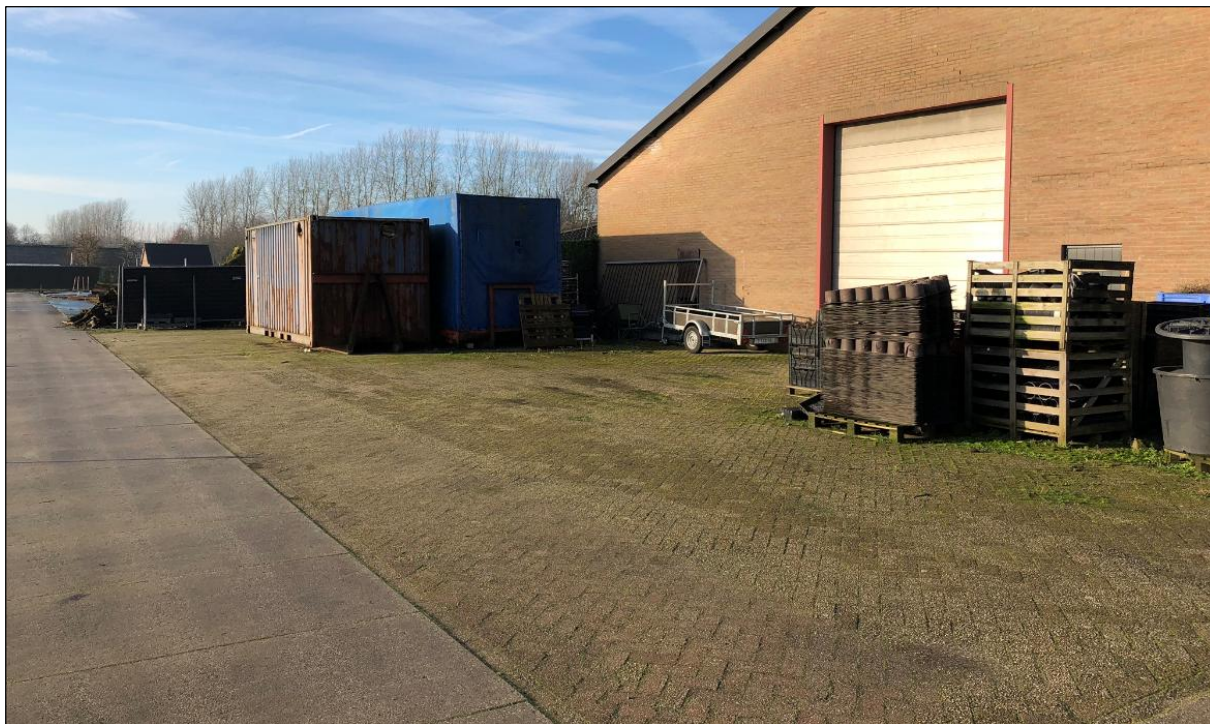
Afbeelding 5: Achterterrein plangebied nabij loods
