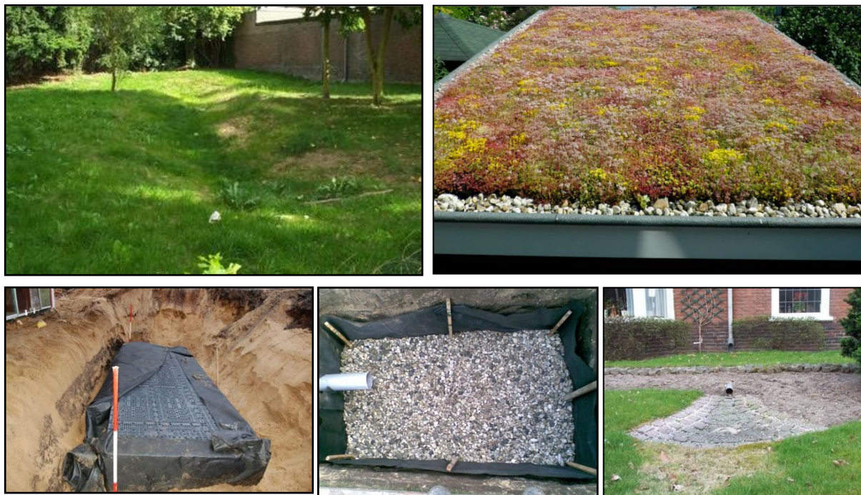
Figuur 32: Voorbeelden infiltratievoorzieningen
