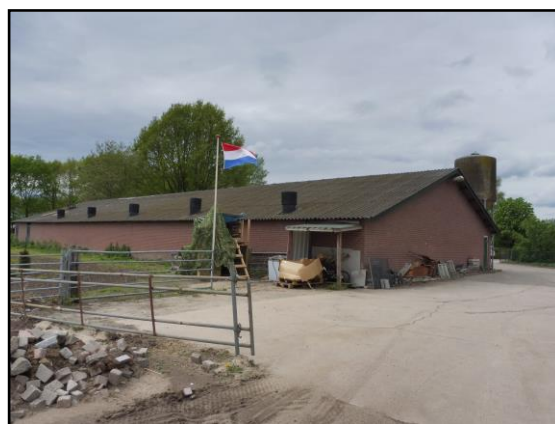
De meest oostelijk gelegen te slopen stal.
