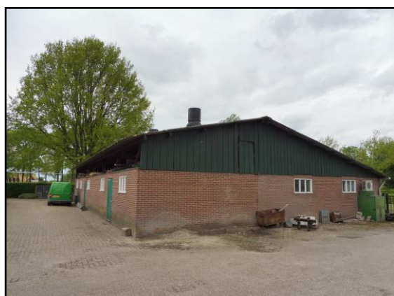
Te slopen stal met open zolderruimte.
