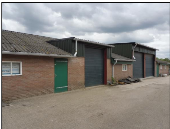
De te slopen stal aan de noordzijde.
