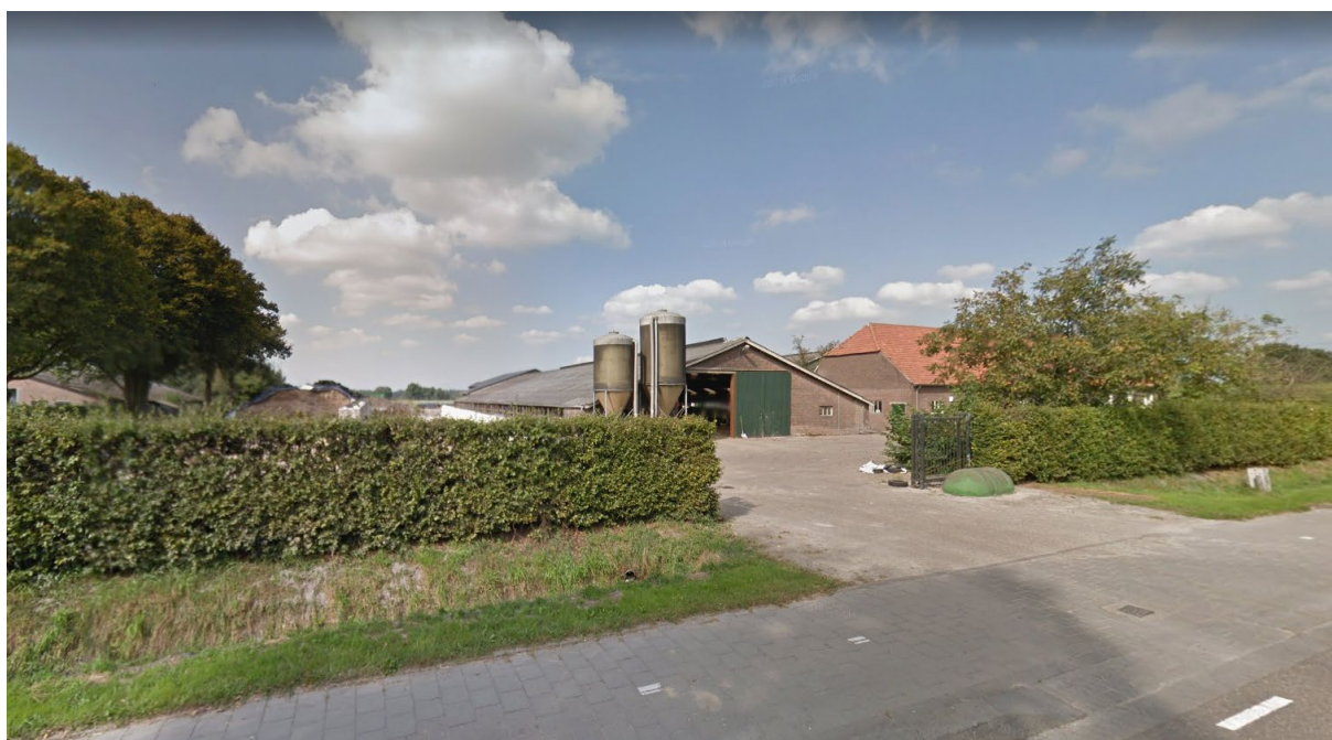
Figuur: aanzichten vanaf de straat (Google Maps).
